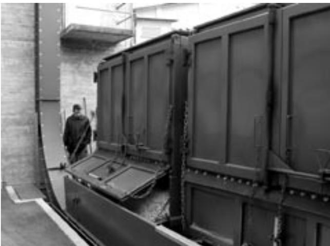
*Rund zwei Drittel des benötigten Brennstoffs werden zugekauft. Dessen Anlieferung erfolgt «just in time» in zwei Rollcontainern zu je 30 m<sup>3</sup>, welche mit Schubböden versehen sind. Ein Kratzkettenförderer transportiert die Schnitzel anschliessend ins Hochsilo.*
