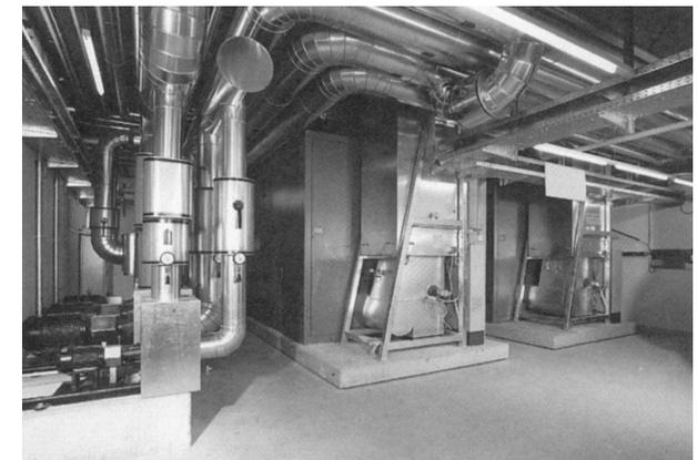
Abb. 7: Energiezentrale des Kantonsspitals Obwalden mit zwei Blockheizkraftwerken (Propan-Magermotoren)
