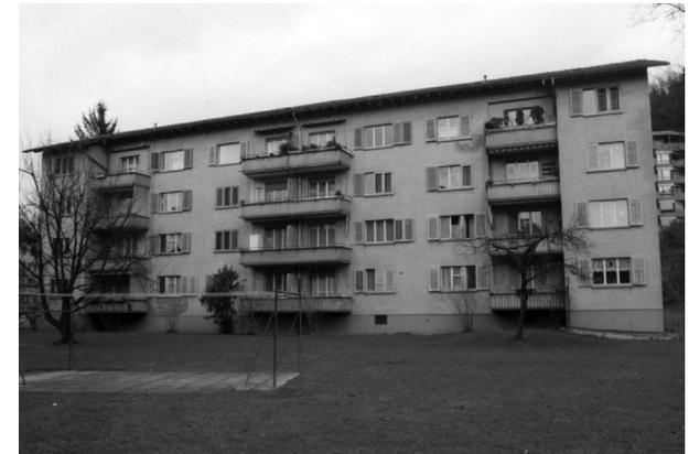
Mehrfamilienhaus mit Untergeschoss, 4 Wohngeschossen und Estrich unter Satteldach mit Ziegeleindeckung. Die Balkone werden durch die auskragende Stahlbetondecke gebildet; insbesondere bei einer zusätzlichen Aussenwärmedämmung gelten diese als gravierende wärmetechnische Schwachstelle.
