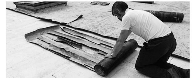
Rückbau einer Flachbedachung mit Kunststoff-Folie (Sarnafil AG)
