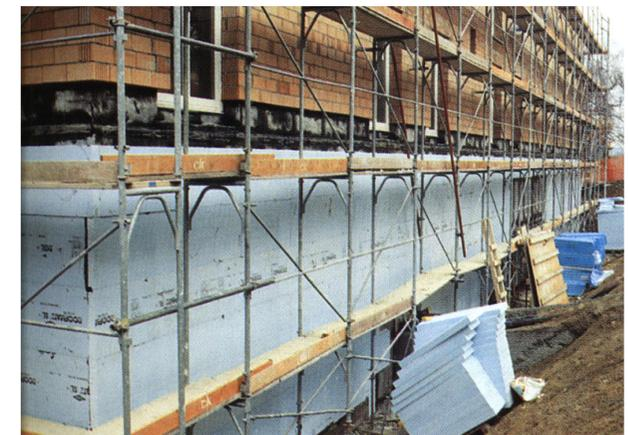
Abb. 3 Wohnsiedlung in Zürich, Aussendämmung mit geklebten Polystyrolplatten
