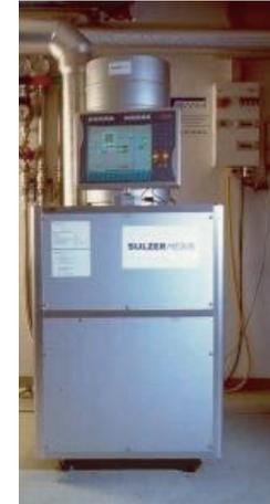
So sieht ein Brennstoffzellen-Heizkessel aus.
