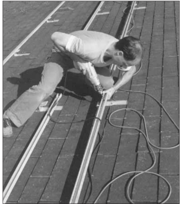
Befestigung der Montage-Ankerschienen
