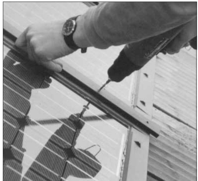
Anschrauben der Alu-Deckprofile
