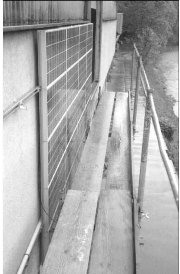
3-kW-Anlage mit Standardmodulen. Befestigung durch Ankerschienen und Alu-C-Profile
