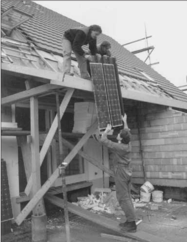
Wekstattseitig geklebte Module
