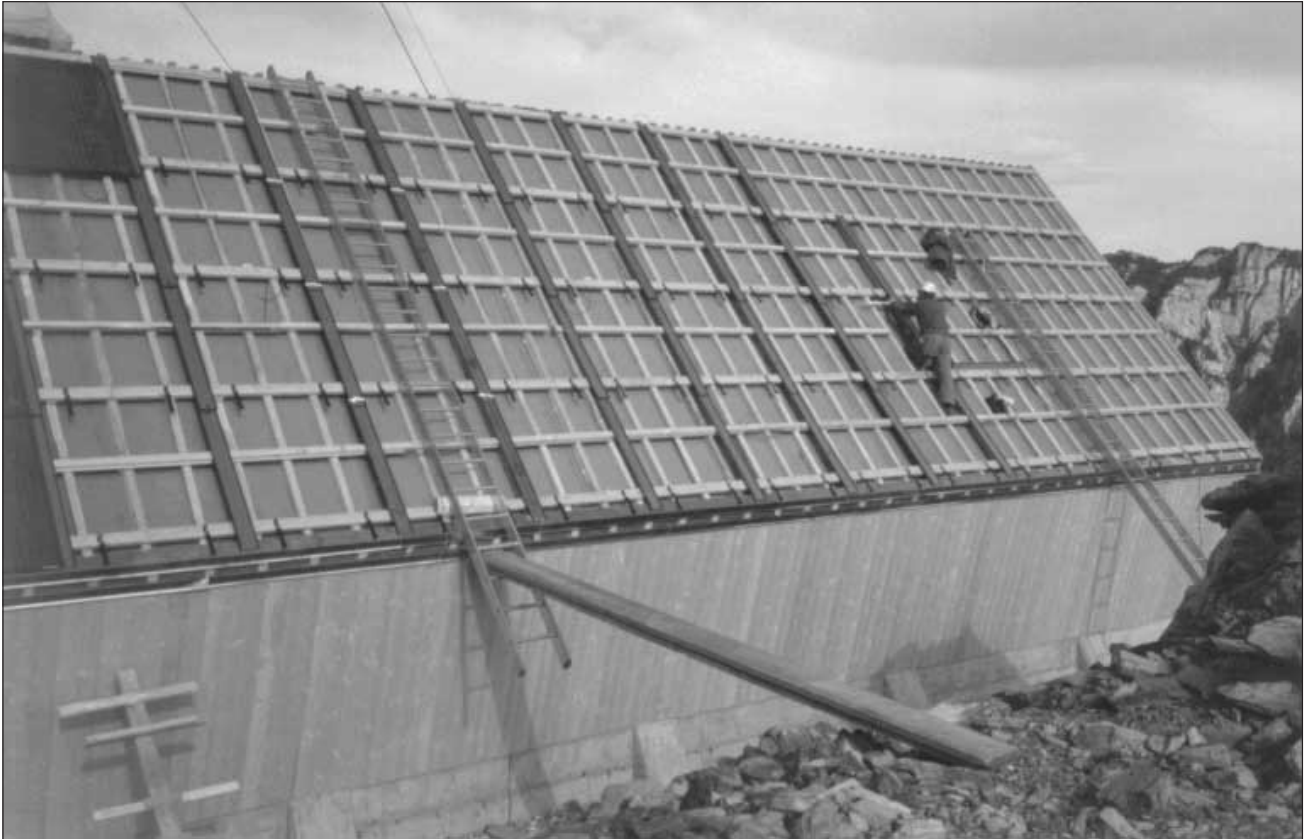
Montage des schieferartigen Solarzellenfeldes
