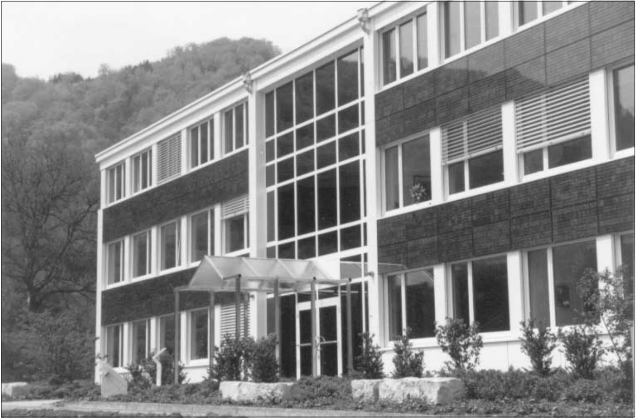
Industriebau mit 8,4-kW-PV-Fassadenanlage
