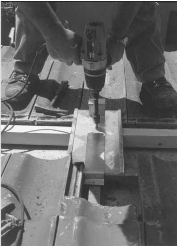
Festschrauben des Montagebügels und Abtropfbleches
