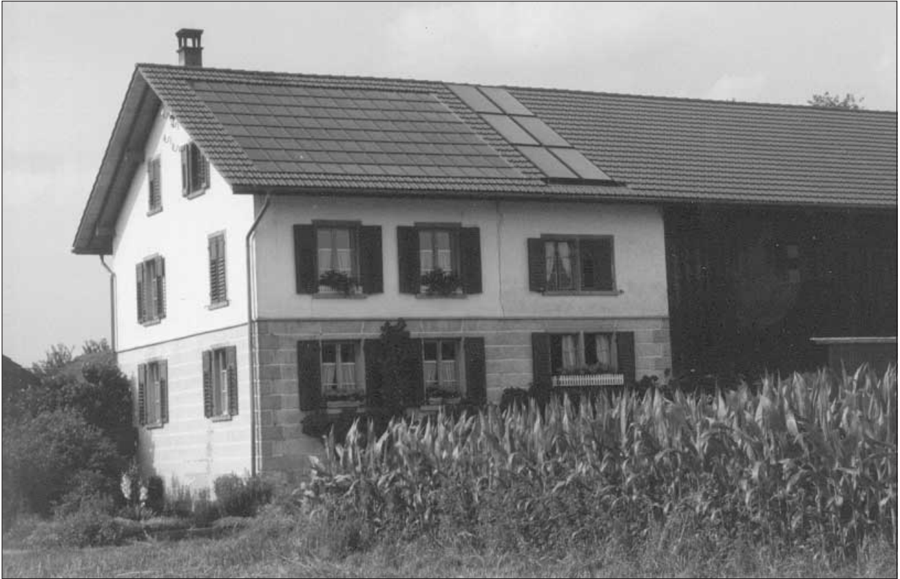
Photovoltaik- und Warmwasserkollektor-Anlage auf dem selben Dach
