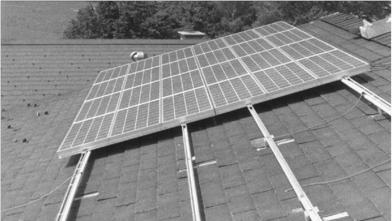
Eternitdach Solarmodule teilweise montiert
