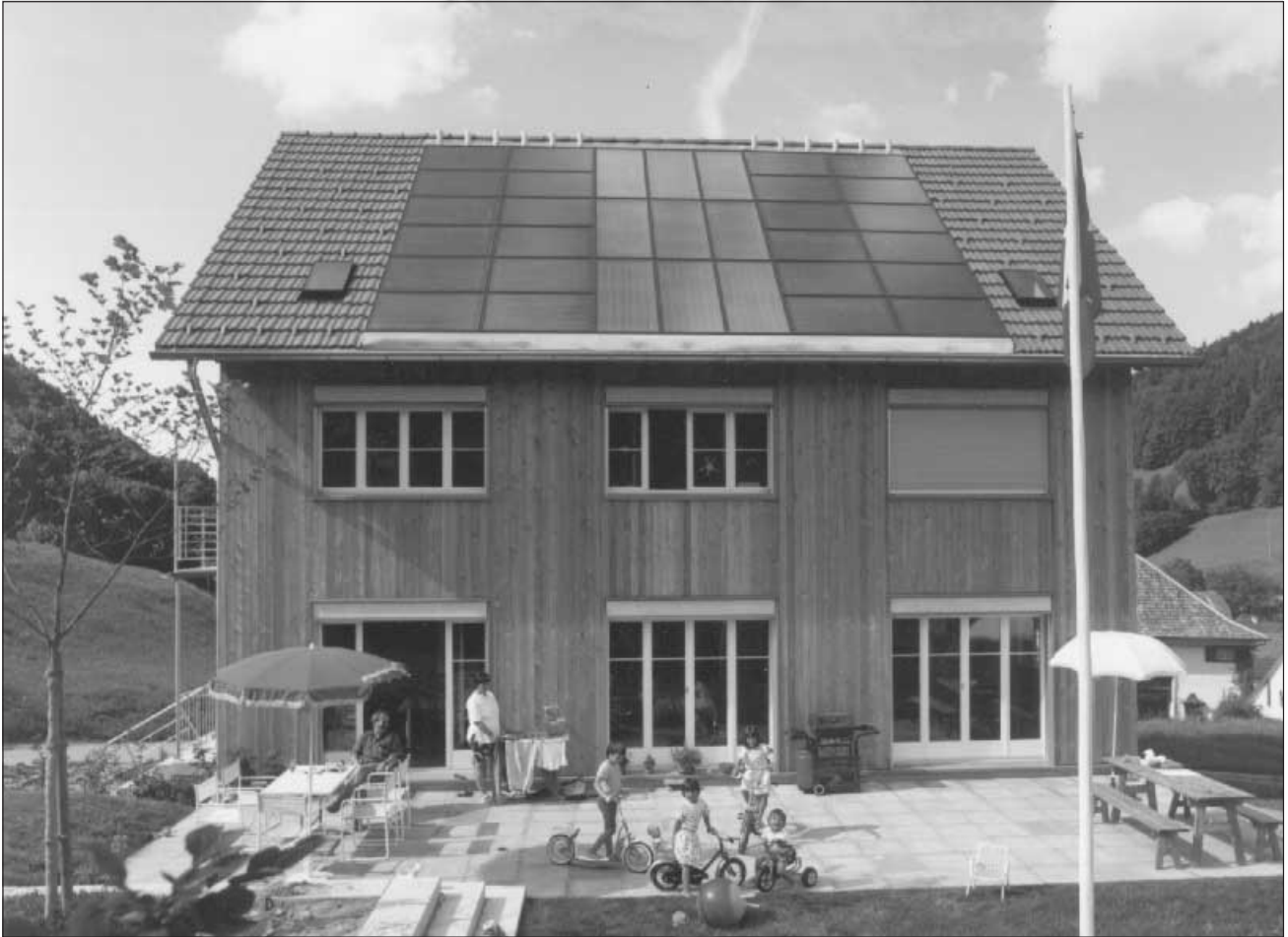
Einbausystem für photovoltaische und thermische Nutzung
