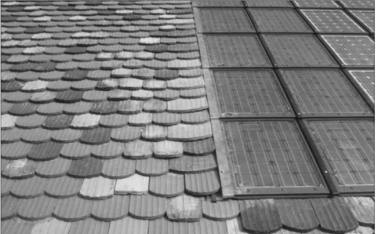
Übergang Solarzellenfeld–Ziegeldach
