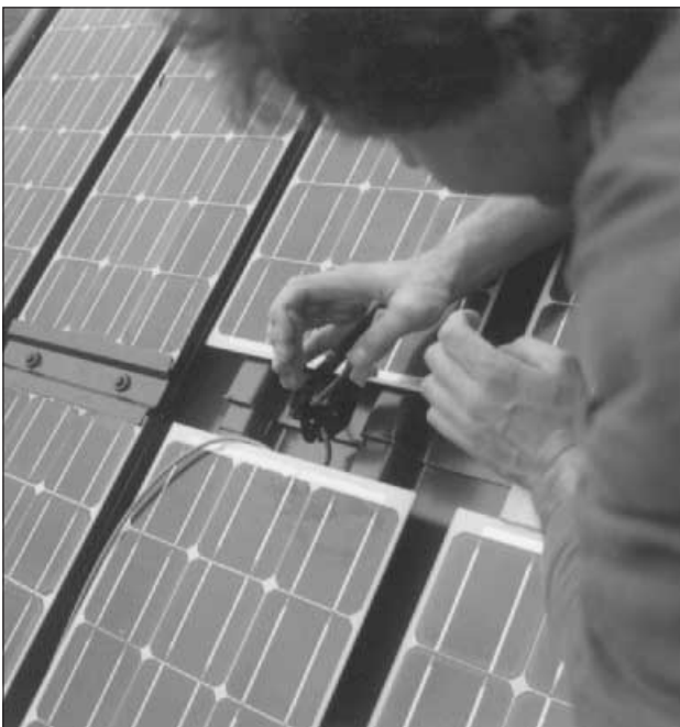
Verdrahtung vor der Verschraubung auf dem Dach
