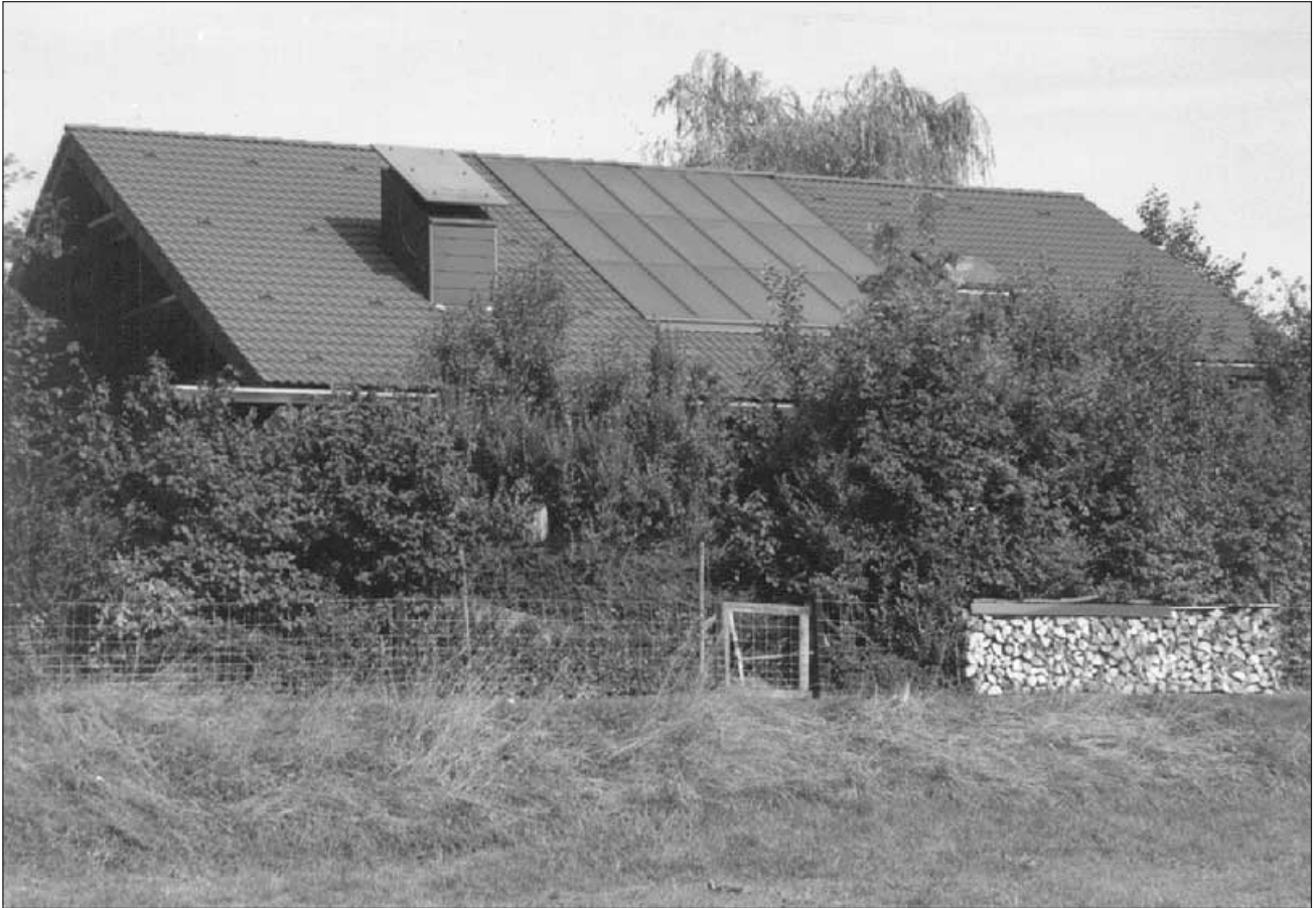
Ansicht einer Einbaukollektor-Anlage
