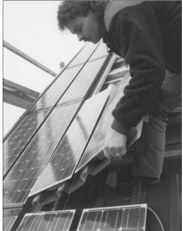
Verlegen der Einheiten auf dem Dach
