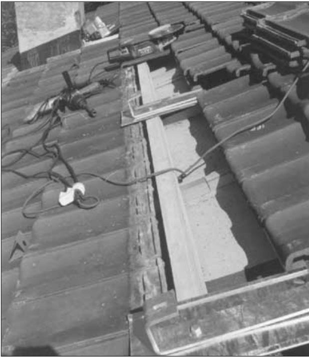
Bilden der ersten Dachdurchführungsreihe
