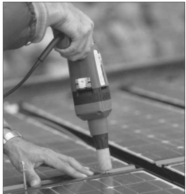
Verschraubung der Sicherheitshalter
