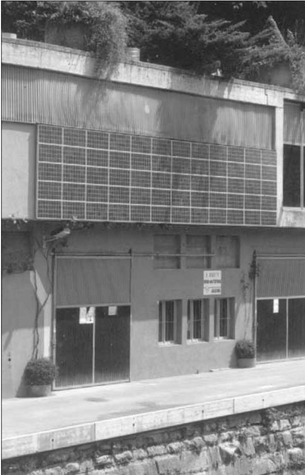
3-kW-Anlage mit Standardmodulen. Befestigung durch Ankerschienen und Alu-C-Profile
