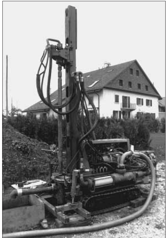
Dank moderner Bohrtechnik stellt die Installation von Erdsonden kein Problem dar.
