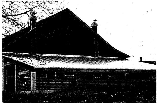
*Dieser Stallanbau enthält als Dach einen Kollektor (190 m<sup>2</sup>) mit durchsichtiger Polyesterabdeckung. Die Luft tritt bei der Traufe in den Kollektor ein, fliesst nach oben und wird vom Heulüfter von beiden Seiten zur Mitte angesaugt.*
