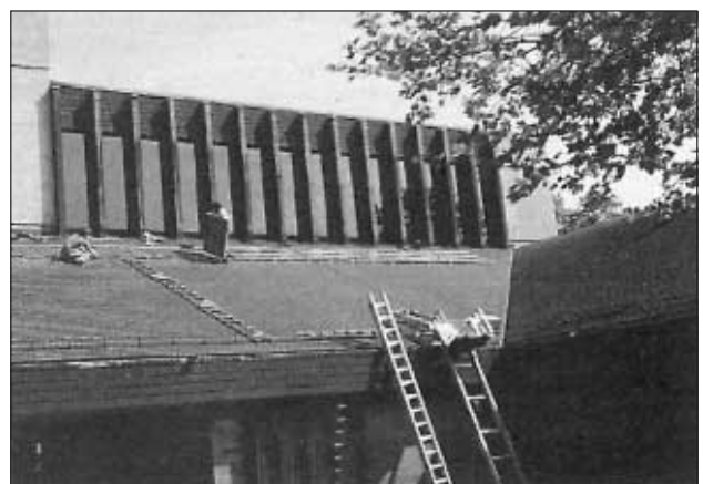
Abb. 3.3: Eine PV-Anlage im Bau
