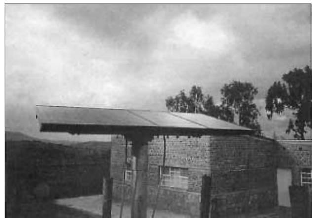
Abb. 2.10: Kleine dezentrale Anlage in Afrika
