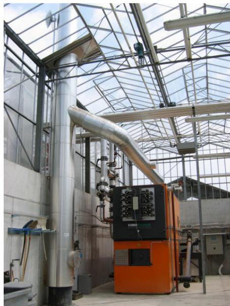
Bild 1: Heizzentrale mit Holzkessel 1'600 kW
