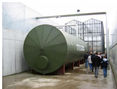
Bild 3: liegender Energiespeicher 100 m<sup>3</sup>
