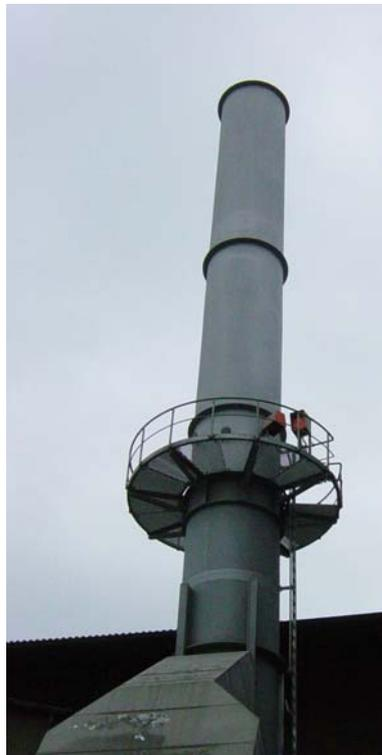
**ABBILDUNG 1:** LINKS: KÜHLTURM, IN DEM HEUTE DIE ABWÄRME VOR DEM STAUBFILTER AN DIE UMGEBUNG ABGEFÜHRT WIRD.
