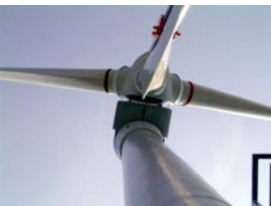
Montage einer Windturbine, Gütsch
