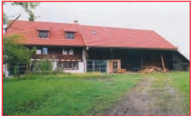
Nur wenige neue Elemente, vorwiegend Fenster für eine bessere Lichtdurchflutung, wurden in den bestehenden Bau integriert, um die Aussenhülle der Liegenschaft möglichst in der herkömmlichen Form zu erhalten.
