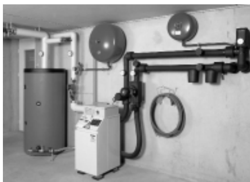
Sole-Erdwärmesonde Wärmepumpenanlage
