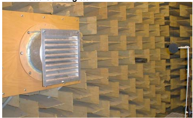
Bild D.4 Wetterschutzgitter im Akustiklabor
