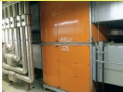
Vor der Sanierung: Alte Luft/Wasser-Wärmepumpe.
