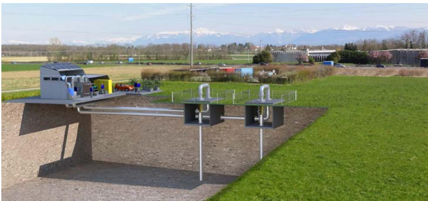
Geothermische Energiezentrale des «mitteltiefen» Geothermieprojektes von EnergieÖ in Vinzel (VD) mit einem Förder- und einem Reinjektionsbrunnen – Fotomontage. Quelle: EnergieÖ
