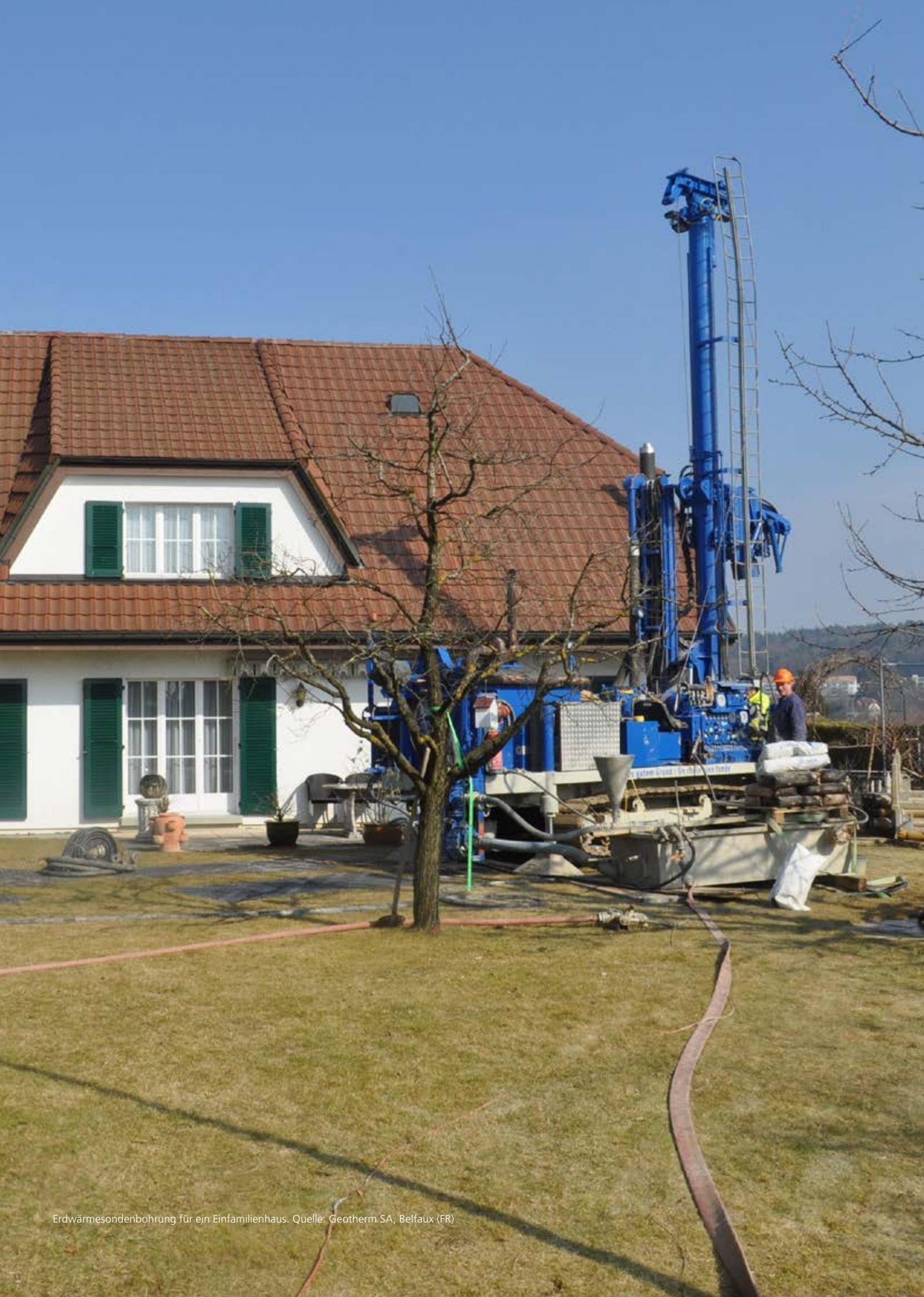
Erdwärmesondenbohrung für ein Einfamilienhaus. Quelle: Geotherm SA, Belfaux (FR)
