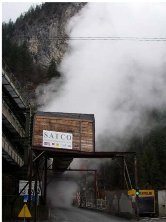
Bergwasser aus Spalten und wasserführenden Gesteinsschichten dringt in Tunnel ein. Die im Bergwasser enthaltene Wärme kann wie z.B. im Tropenhaus Frutigen (Bild Seite 8) für Wärmezwecke genutzt werden. Quelle: CREGE
