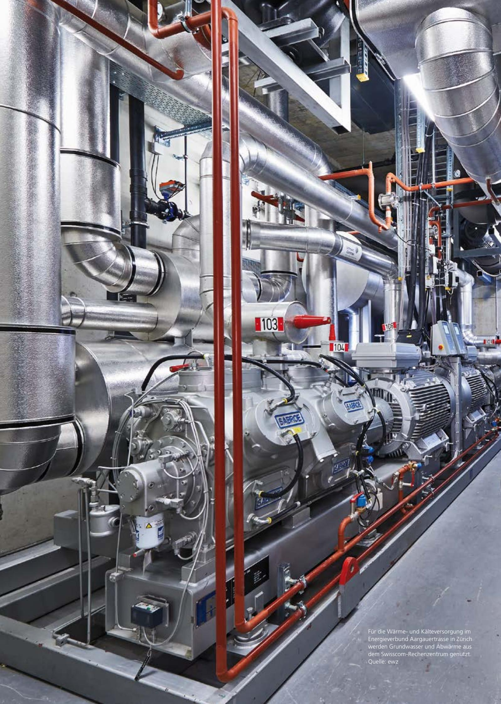
Für die Wärme- und Kälteversorgung im Energieverbund Aargauertrasse in Zürich werden Grundwasser und Abwärme aus dem Swisscom-Rechenzentrum genutzt. Quelle: ewz
