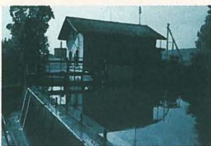
Abteufen einer Erdwärmesonde vor einem Mehrfamilienhaus in Zürich (oben) und Teilansicht des Kleinwasserkraftwerkes in Hünenberg bei Zug (unten).
