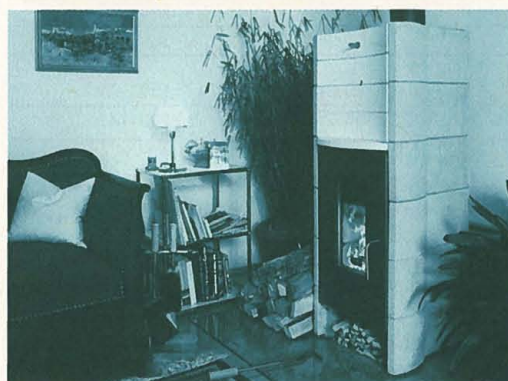
Zwei effiziente Klein-Holzfeuerungen: Stattlicher Stubenofen mit Sitzkiste in einem Einfamilienhaus (links), wohlige Wärme aus einem Zimmerofen mit Glastüre (rechts).
