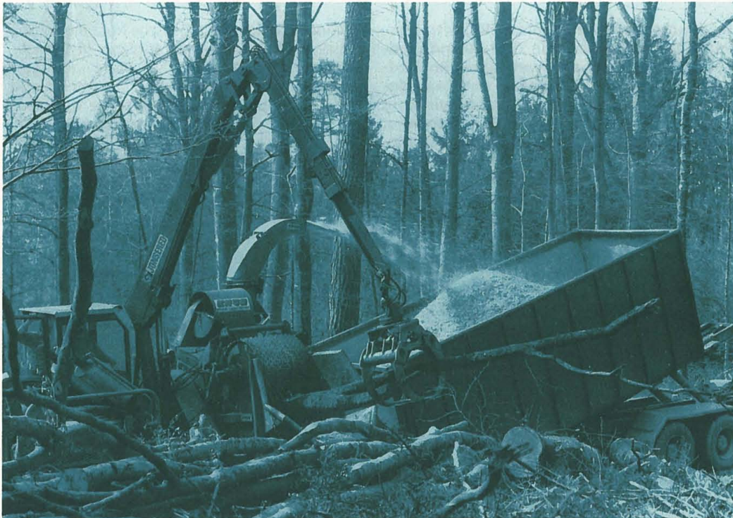
Mobile Shredderanlage zur Produktion von Holzschnitzeln (links), Heizzentrale in Altdorf mit Holzschnitzelfeuerung zur Versorgung mehrerer Bauten über ein Wärmenetz.
