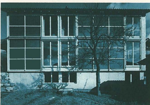
Einfamilienhaus neu verpackt: Transparente Wärmedämmung in Ormalingen.
