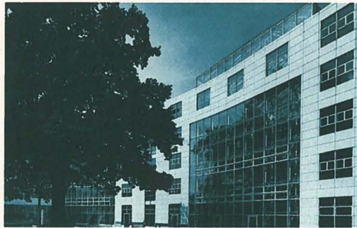
Tageslichtnutzung und Vorwärmung der Zuluft über grosse Atrien im Bürohaus Grafenau in Zug.
