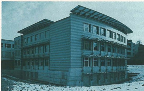
Sonnenschutz mit Brisesoleils, stundenplangesteuerte Ersatzluftanlage, Einzelraumregelung der Heizung und bedarfsabhängige Beleuchtungssteuerung – vier vorbildliche Massnahmen im Oberstufenschulhaus Sirnach.
