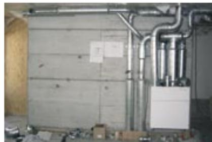
Einzelwohnungs-Komfortlüftung bei einer Küchensanierung. Einfache und schöne Lösung: Lüftungsleitungen und Lüftungsgerät sind geschickt hinter der Küchenkombination «versteckt».
