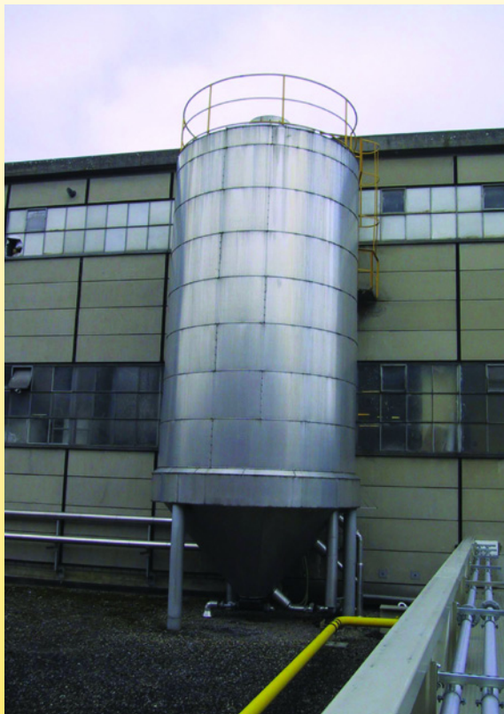
100 m 3 Warmwasserspeicher.
