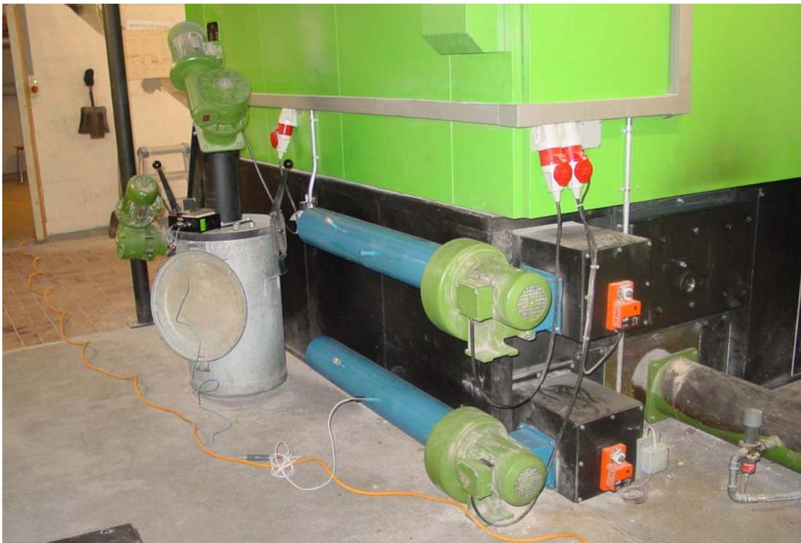
Bild 8.1: Zuluftventilatoren mit vorgeschalteten Rohren zur Bestimmung der Zuluftvolumenströme mit Hilfe eines Flügelradanemometers.
