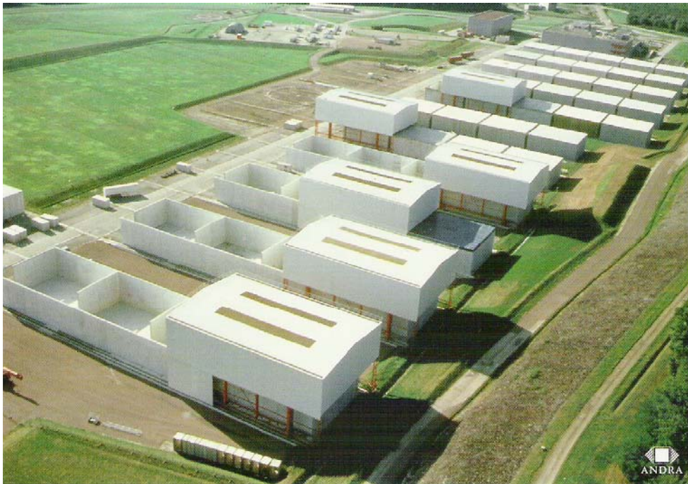
Abbildung 45: Centre de l'Aube, Einlagerungshallen
