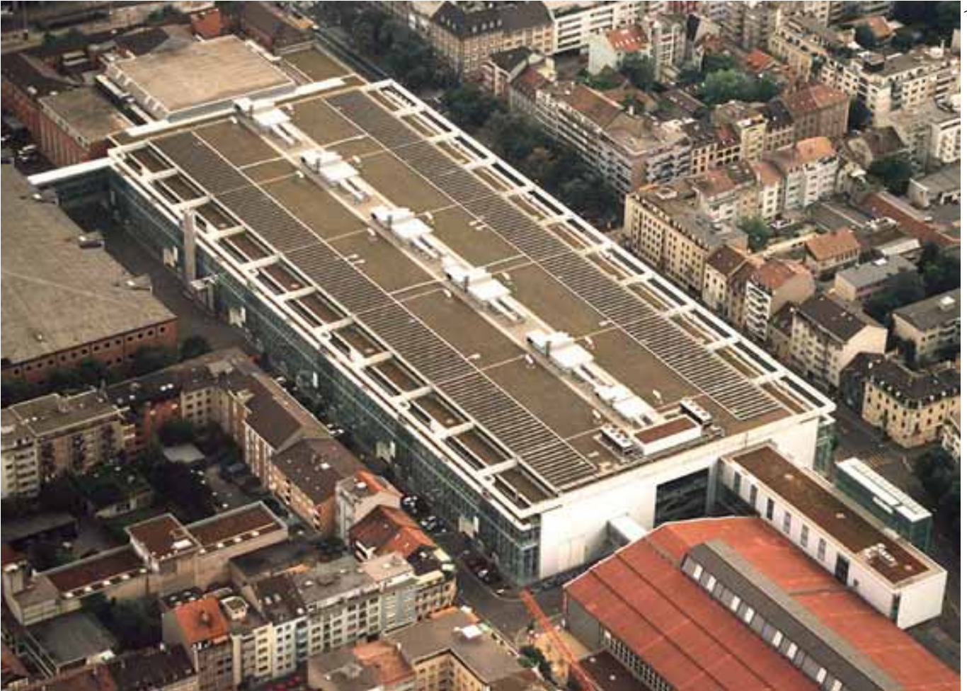
Abbildung 11: Messe mit Solarstrom. Auf dem neuen Messegebäude 1 in Basel steht eine Photovoltaikanlage mit 240 Kilowatt Leistung. Quelle: energiebüro Zürich
