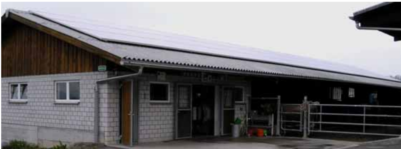
Abbildung 23: Photovoltaikanlage auf dem Laufstall in Zürich. Die grösste Anlage dieser Solaraktion erzielt mit 120 Solarmodulen eine Leistung von 19,8 kW. Quelle: BE Netz, Luzern
