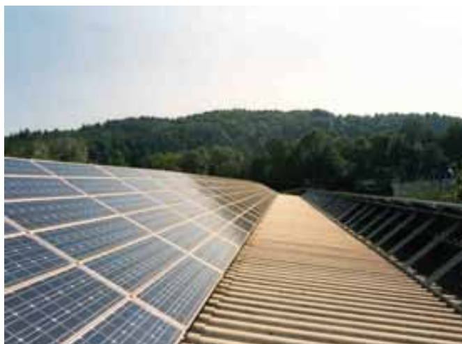
Abbildungen 14 und 15: Solarstrom in Burgdorf. Beispiele für Burgdorfer Photovoltaikanlagen sind die aufgeständerten Installationen auf dem Gebäude der Localnet AG Gesteig mit 16,3 kW Leistung sowie auf dem Schulhaus Schlossmatt mit 3,2 kW Leistung. Quelle: Photovoltaiklabor der HTI der Berner Fachhochschule, weitere Informationen: www.pvtest.ch
