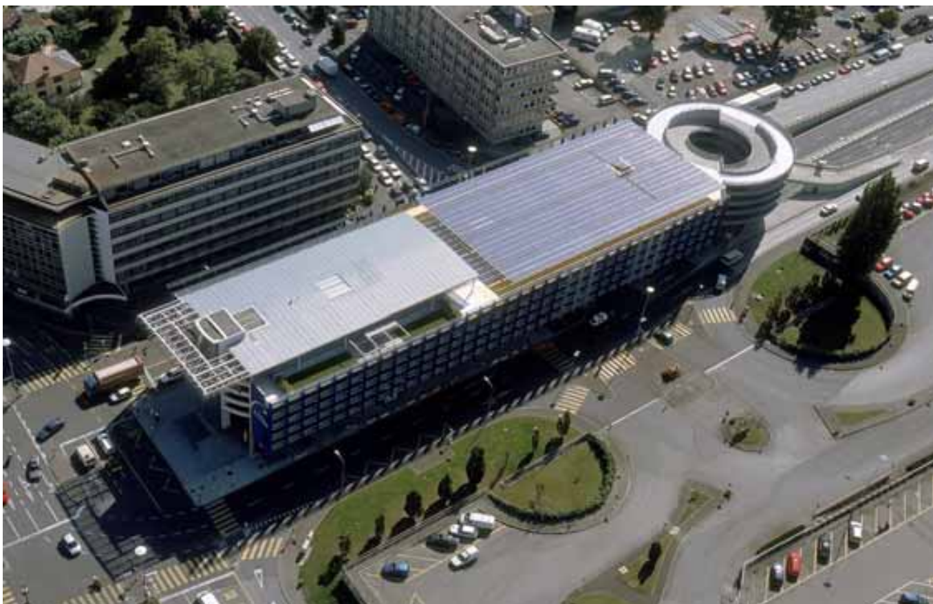
Abbildung 19: Parkhaus mit Solarstrom in Genf. Auf dem Dach des Parkhauses „Etoile“ wird Solarstrom erzeugt und in das Netz der Industriellen Betriebe Genf eingespeist. Quelle: Sunwatt Bio Energie, Chêne-Bourg
