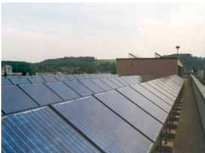
Abbildungen 14 und 15: Solarstrom in Burgdorf. Beispiele für Burgdorfer Photovoltaikanlagen sind die aufgeständerten Installationen auf dem Gebäude der Localnet AG Gesteig mit 16,3 kW Leistung sowie auf dem Schulhaus Schlossmatt mit 3,2 kW Leistung. Quelle: Photovoltaiklabor der HTI der Berner Fachhochschule, weitere Informationen: www.pvtest.ch
