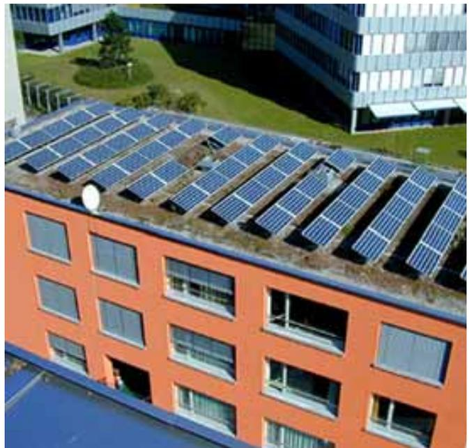
Abbildung 31: **Aufgeständerte Gründachlösung in Zürich.** Solgreen Montagestruktur erlaubt eine angepasste Lösung (Abstand zur Dachfläche, Fixierung der Unterkonstruktion auf dem Dach) auf dem Gebäude der Zürcher Wohn- und Baugenossenschaft. Quelle: NET, St. Ursen
