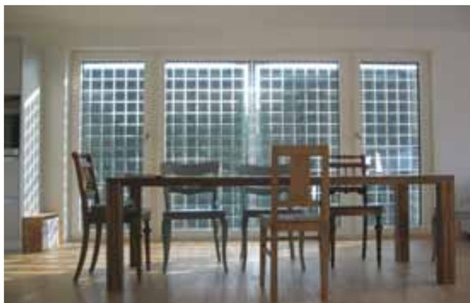
Abbildungen 79 und 80: **Solare Fensterläden.** Aussen- und Innenansicht der innovativen und solaraktiven Flügel der Fensterläden. Die Photovoltaik Elemente des Einfamilienhauses mit Passivhaustechnologie in Pratteln (BL) weisen eine Gesamtleistung 3,1 von kW auf. Quelle: R. Miloni, Mülligen
