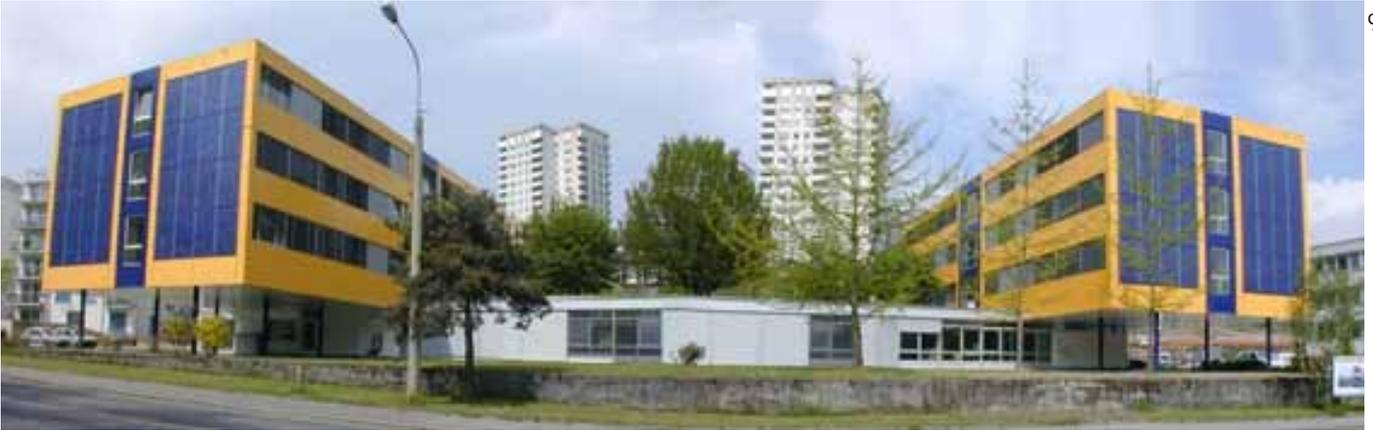
Abbildungen 32: **Fassadenintegration in Lausanne.** Studierendenheim Rhodanie mit fassaden-integrierten Photovoltaikanlagen in farblich auffälliger und gefälliger Komposition. Quelle: Services Industriels de Lausanne
