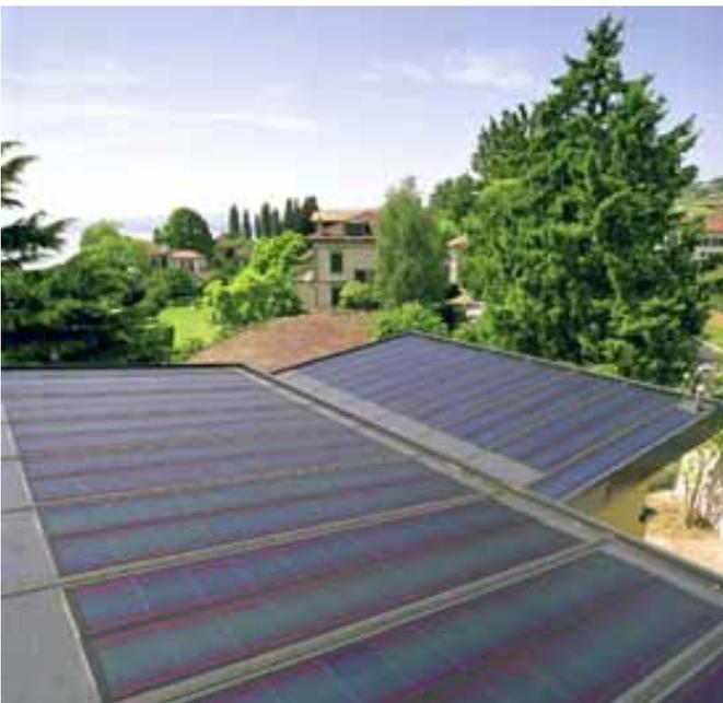
Abbildung 30: **Dachintegration Freestyle mit Dünnschichtzellenmodulen in Lutry (VD).** Das neue Einfamilienhaus wurde mit integrierten Dünnschichtzellenmodulen gebaut. Die Photovoltaikanlage (5,5 kW) ist vom Boden aus nicht erkennbar. Quelle: NET, St. Ursen
