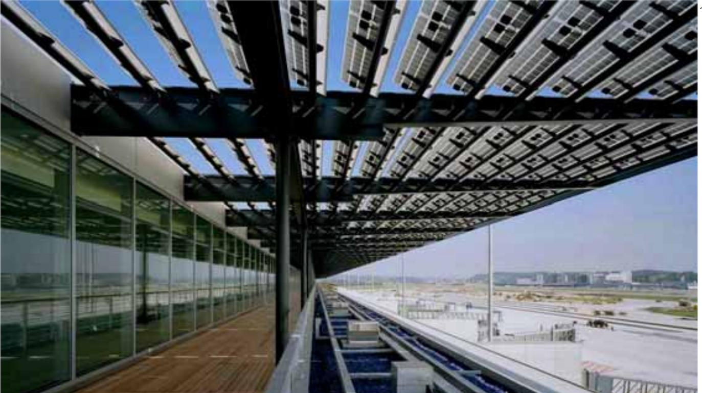
Abbildung 34: **Solare Beschattungsanlage am Flughafen Zürich-Kloten.** Die BesucherInnenenterrasse ist mit einer Photovoltaikanlage überdacht. Quelle: unique / Ralph Bensberg
