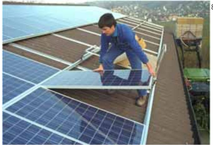
Abbildung 27: **Aufbau- oder Aufdachlösung.** Quelle : BE Netz, Luzern
