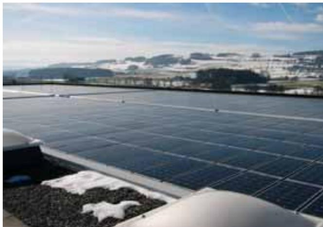
Abbildungen 68 und 69: **Solardachplatten**. Solardachplatten auf Hochregallager in Triengen (LU). Auf dem Flachdach werden in Form eines Umkehrdaches Solardachplatten verlegt, welche aus einer 5 cm dicken Isolationsschicht und je 2 rahmenlosen Solarmodulen bestehen. Die Anlage hat eine Leistung von 62,4 kW. Quelle: Zagsolar Kriens (LU)
