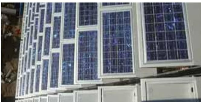
Abbildungen 48 bis 50: **Renovation und innovatives Design beim niederländischen Energieforschungszentrum.** Bei Renovationsarbeiten und beim Anbau sind insgesamt 102,9 kW Solarkraft integriert worden. Die Bilder zeigen eine Innen- und Aussensicht des geschwungenen, semi-transparenten Photovoltaikdaches sowie eine Sicht (von oben) auf die Module der Photovoltaikfassade. Quelle: ECN, Niederlande / BEAR Architecten, Niederlande
