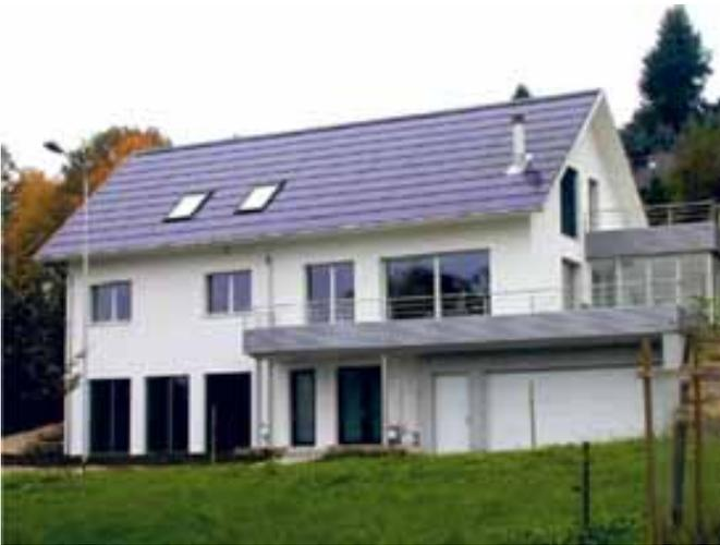
Abbildung 28: **Vollflächige Indachlösung.** Quelle: Eneco, Mönchaltorf
