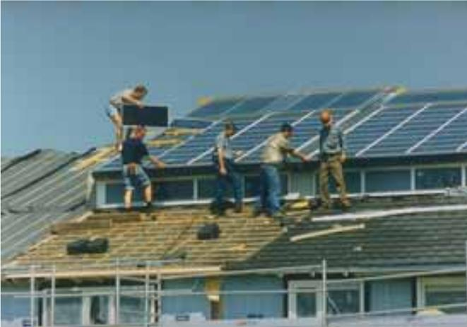
Abbildung 26: **Einbau- oder Indachlösung.** Quelle: Ecofys Niederlande
