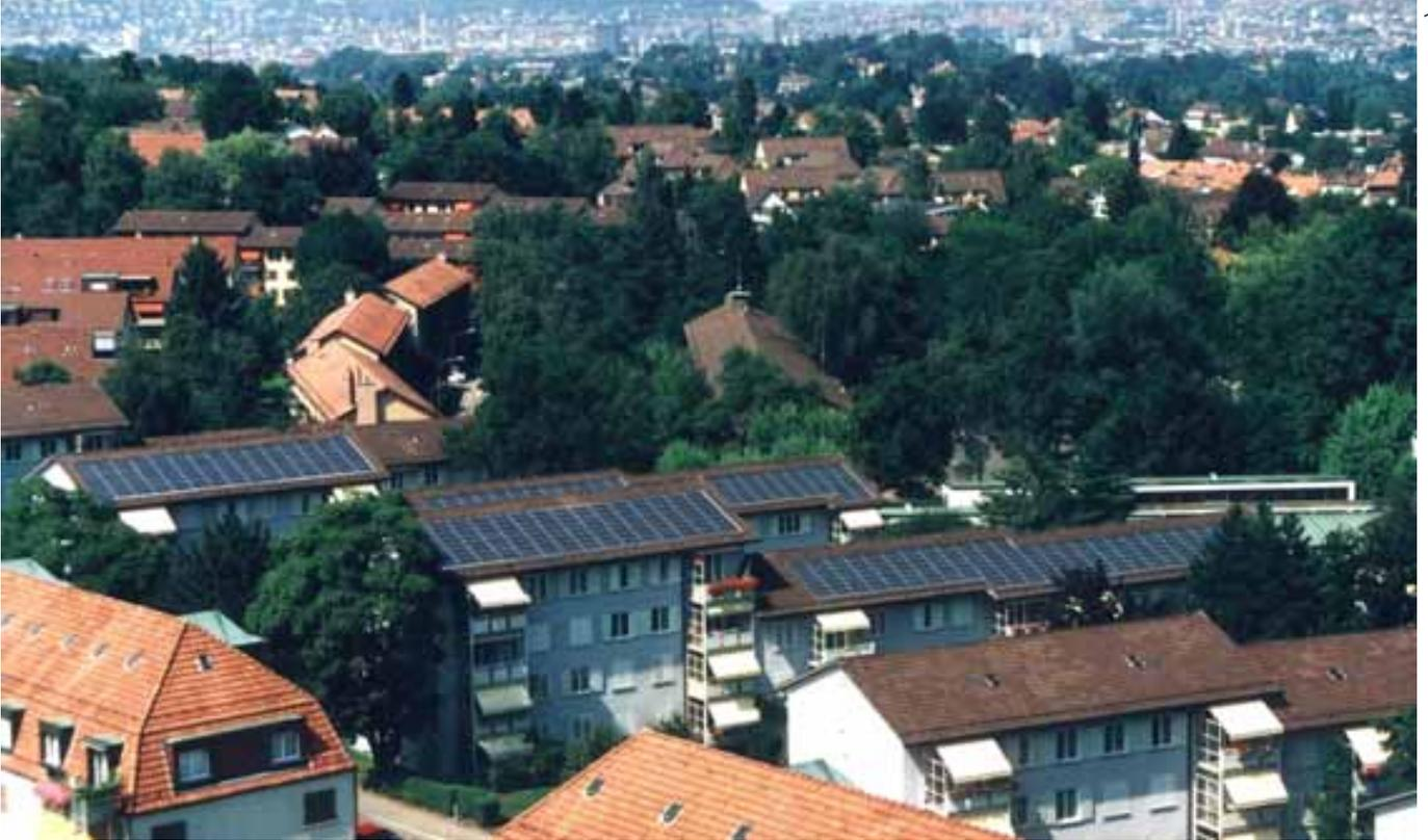
Abbildung 51: **Renovation der Mehrfamilienhäuser mit Photovoltaik in Zürich.** Die Baugenossenschaft hat bei den Renovationsarbeiten der Mehrfamilienhäuser mehrere Photovoltaikanlagen in die Schrägdächer integriert. Quelle: Enecolo, Mönchaltorf
