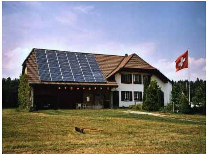
Abbildung 29: **Teilflächige Aufdachlösung.** Quelle: M. Gutschner, Freiburg i. Ue.
