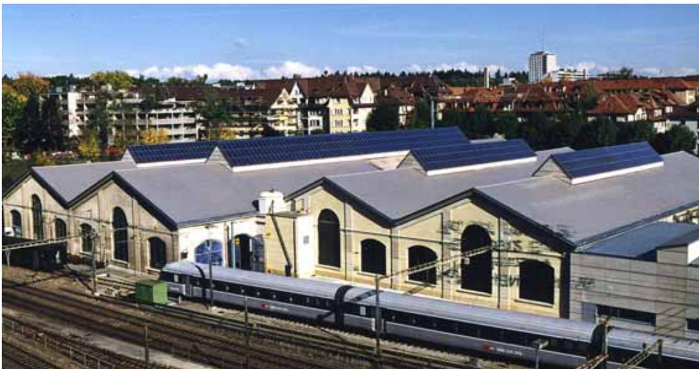
Abbildung 54: **Solarstromanlage und Heimatschutz in Bern.** Das Lokomotivdepot in Bern erhält natürliches Tageslicht durch die semi-transparenten Oberlichter und viel Lob vom Schweizer Heimatschutz für die gelungene Integration der Solartechnologie in den schützenswerten Bau. Quelle: NET, St. Ursen
