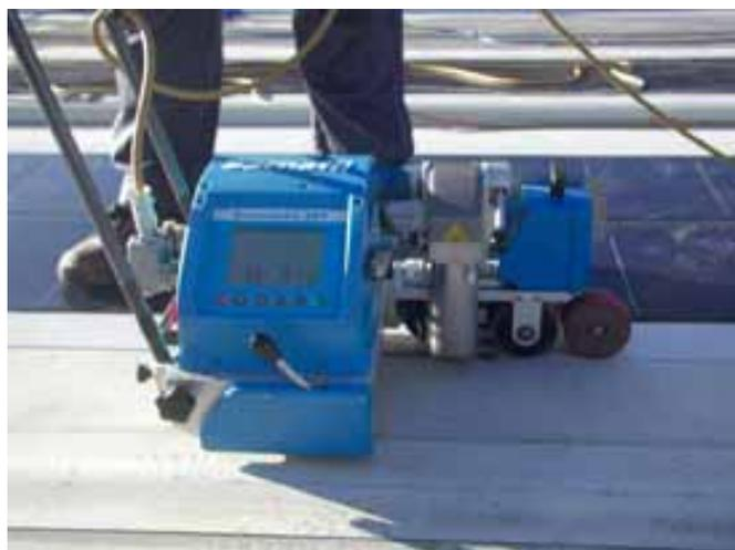
Abbildungen 66 und 67: **Flexible Solarmembrane.** Flexible Dachlaminatlösungen mit Photovoltaik. Das Anbringen von Solarmembranen erfolgt gemäß üblichen Standards und Techniken. Die Membrane werden aus der Transportkiste herausgehoben, auf die vorgesehene Stelle gelegt und danach mit der Unterlage verschweisst. Die flexiblen Elemente können für den Transport standardmässig auf Rollen ausgeliefert werden. Quelle: Laboratorio Energia Ecologia Economia (LEEE)
