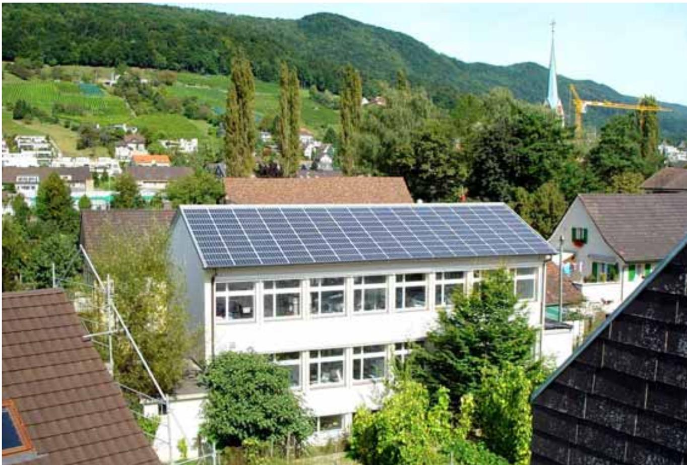
Abbildung 53: **Gemeinsam zur Photovoltaikanlage in der Dorfkerzone Wettingens (AG).** Dach und Solaranlage bilden eine flächendeckende Einheit beim renovierten Gebäude der SKK in Wettingen (AG). Auf Grund des Standorts in der Dorfkerzone sind bei der Planung die wichtigen Akteure mit den Behörden zusammengekommen und haben Lösungen unter Einhaltung des Ortsbildschutzes erarbeitet und umgesetzt. Quelle: Hans-Dietmar Koepfel, SKK Landschaftsarchitekten AG, Wettingen
