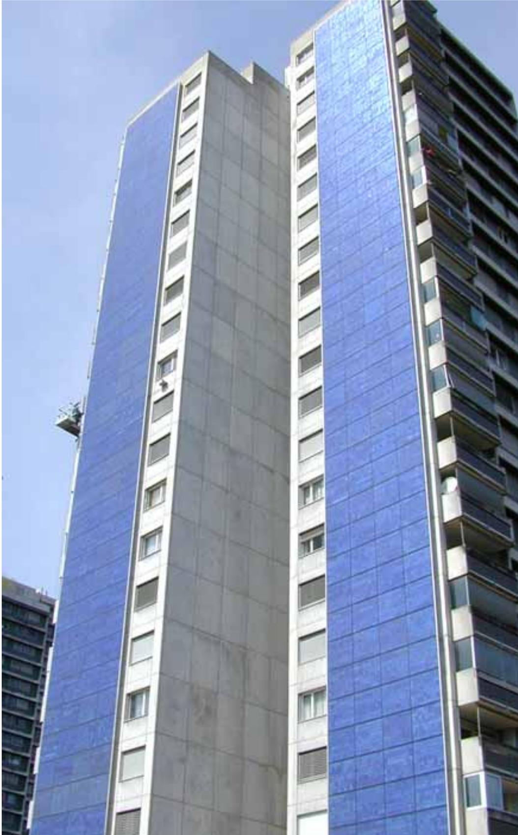
Abbildung 88: **Europas grösstes fassaden-integriertes Solarkraftwerk steht in Bern Wittigkofen.** Mit einer Leistung von 80 kW ist die Photovoltaikanlage in Wittigkofen seit 1998 das grösste fassaden-integrierte Solarkraftwerk Europas. Der Solarstrom wird von Energie Wasser Bern (ewb) an ÖkostromkundInnen verkauft. Quelle: NET, St.Ursen
