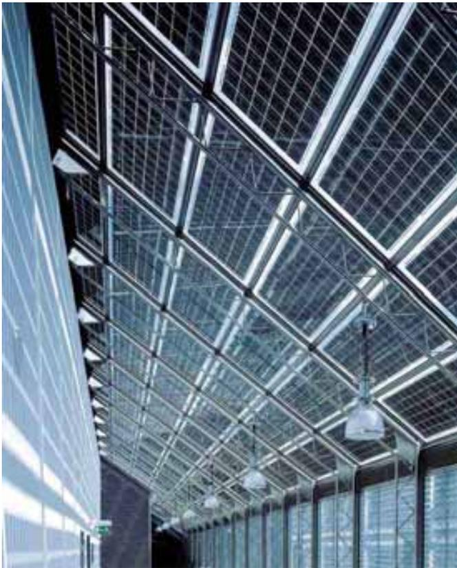
Abbildung 81: **Bankgebäude mit nachhaltigem Design.** Innenaufnahme der Bayerischen Landesbank in München (D). Die installierte Leistung beträgt insgesamt 68 kW. Quelle: Saint Gobain Glass Solar, Deutschland
