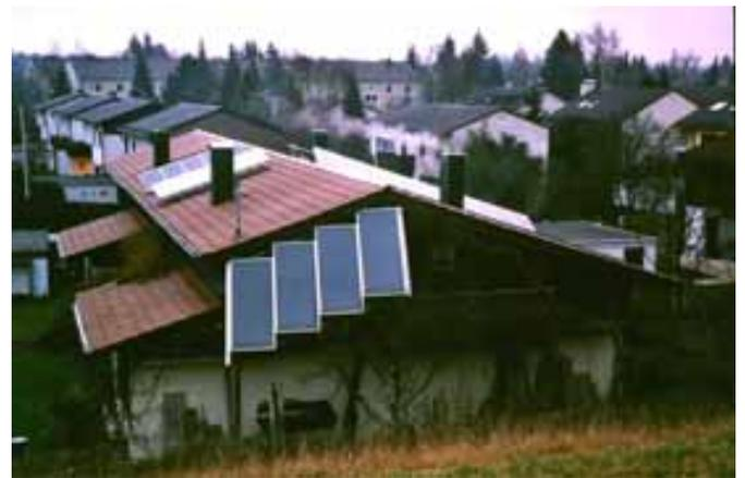
Abbildung 45: **"Integration" – kritisches Beispiel aus Krailling (D).** Das gut gemeinte Engagement der HausbewohnerInnen ist spürbar. Dennoch stellt sich die Frage, ob die Kollektoren und Module nicht ästhetischer integriert werden können. Rechtfertigt der energetische Mehrertrag durch erhöhte Neigung der solaraktiven Flächen diese Aufständerei? Quelle: M. Gutschner, Freiburg i.Ue.
