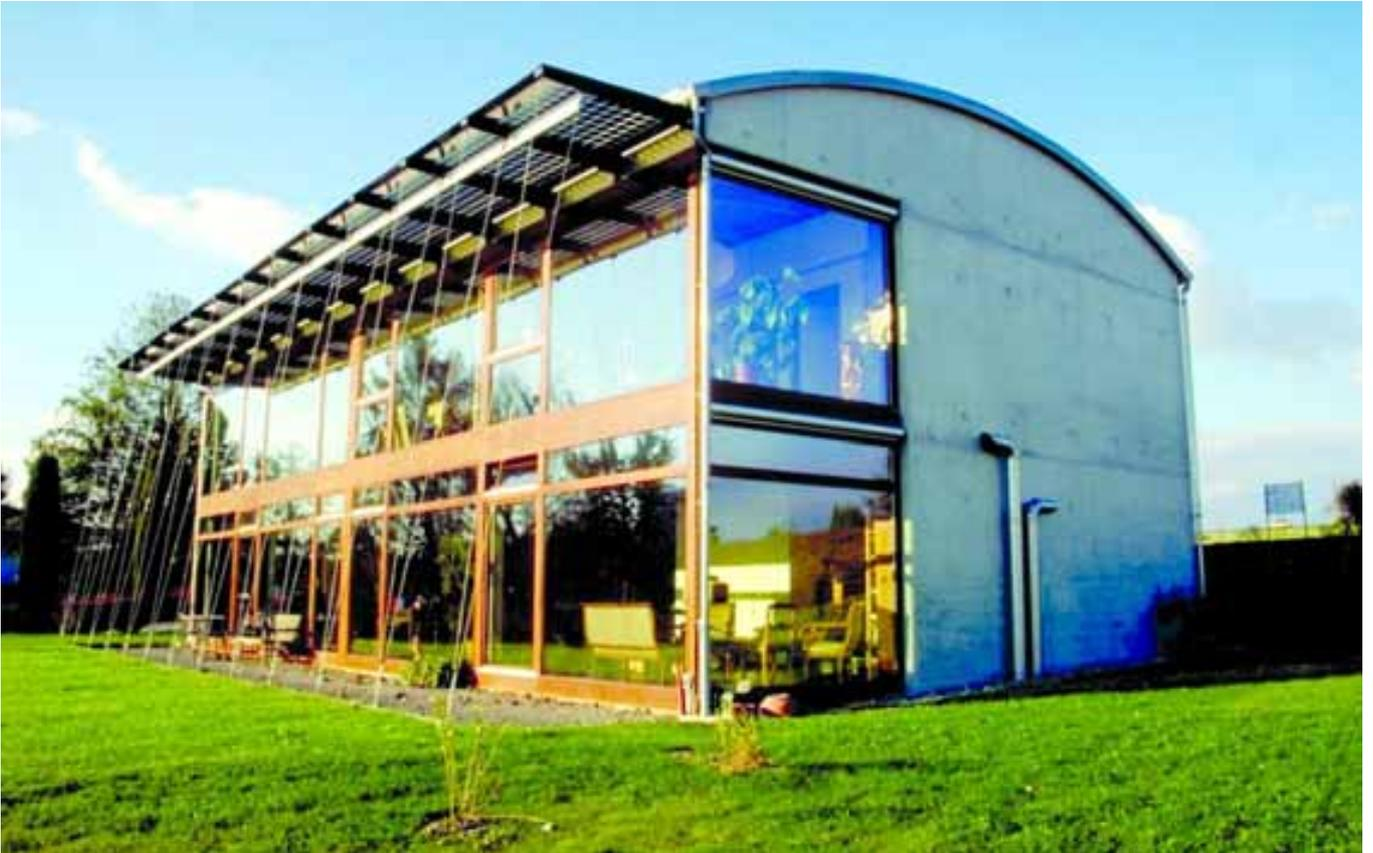
Abbildung 35: **Vordach-integrierte Photovoltaikanlage in St-Sulpice (VD).** Die Familie Probst setzt auf Sonnenenergie. Das photovoltaische Vordach schützt vor zu starker Einstrahlung und produziert gleichzeitig Solarstrom. Quelle: Solstis, Lausanne
