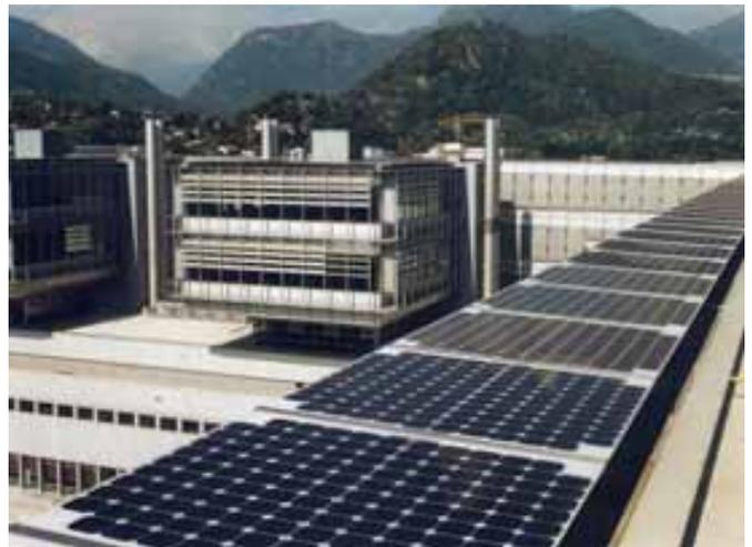
Abbildungen 46 und 47: **Neubau Bürogebäude in Manno (TI)**. Der Neubau des Bürogebäudes Suglio umfasste von Beginn an verschiedene Photovoltaiksysteme (Flachdach, Dachbrüstung und Fassade) im Gesamtenergiekonzept. Quelle: Enecolo, Mönchaltorf
