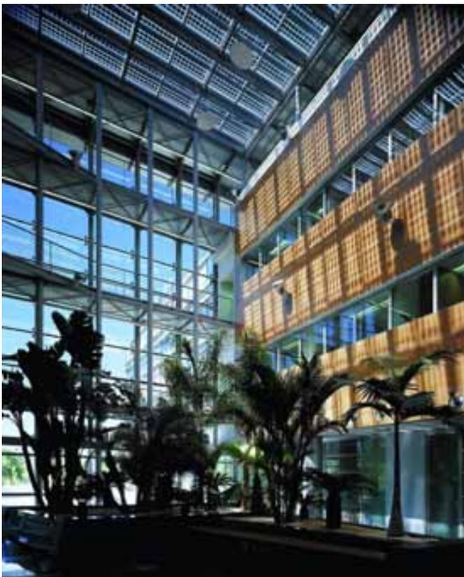
Abbildung 83: **Lichtdurchflutete Vorhalle.** Die semitransparente Photovoltaikanlage der STM in Plan-les-Ouates (GE) erzeugt ein angenehmes Ambiente und jährlich 25'000 kWh Solarstrom. Quelle: AMA Group / Engeco Synergies, Italien
