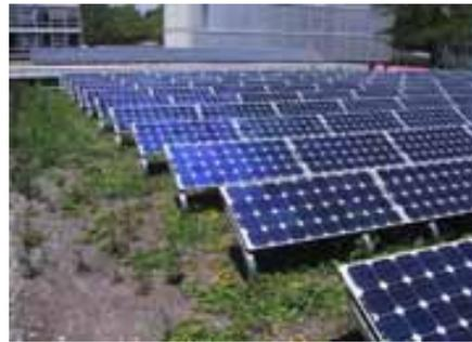
Abbildungen 36 bis 43: **Tragstrukturen für Module auf Flachdächern.** Verschiedene Leicht- und Schwergewichtslösungen, die auch teilweise für Gründächer eingesetzt werden können. Abgebildet sind (vlnr) die Modelle Solbac, Solmax, ConSole, Amax, Alustand, Sofrel98, Sofrel95 und Solgreen. Quellen: Enecolo, Mönchaltorf (36, 40 bis 43) / Solstis, Lausanne / Ecofys, Niederlande / Amax, Gland / Alustand, Cham,
