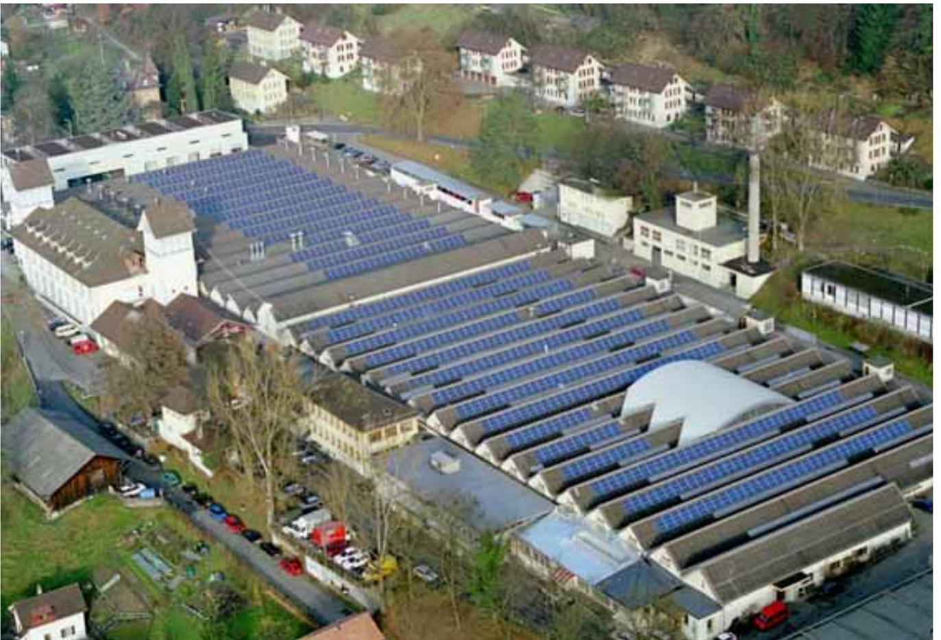
Abbildung 33: **Solarstromanlage auf Sheddach des Gewerbeparks Felsenau in Bern.** Die Photovoltaikanlage produziert mit einer installierten Leistung von 250 kW rund 225'000 kWh Premium Solar Strom für Energie Wasser Bern (ewb). Quelle: S.A.G. Solarstrom, Bern
