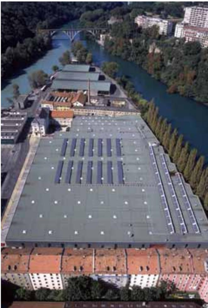
Abbildung 8: **Dach-Flächenpotenzial im Grossformat.** Auf der Zentrale der Transports Publics Genevois (TPG) steht mit 154 kW Leistung eine der grössten Photovoltaikanlagen der Schweiz. Mit den geneigten Modulflächen wird der Solarertrag erhöht. Dies bedingt jedoch einen grösseren Abstand zwischen den Modulreihen, um Verschattung zu vermeiden. Quelle : Sunwatt Bio Energie, Genève
