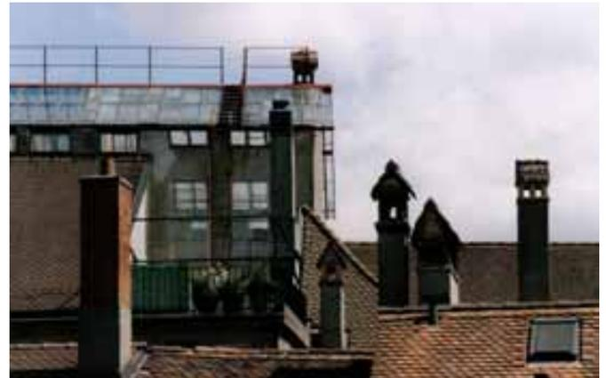
Abbildung 13: **Aufbauten werfen Schatten aufs Flächenpotenzial.** Solararchitektonisch ungeeignet ist diese Fläche für die Photovoltaik. Zu viele Aufbauten brauchen nicht nur entsprechende Flächen, sondern beeinträchtigen durch Schattenwurf wesentlich die photovoltaische Nutzung. Quelle : M. Gutschner, Freiburg i.Ue.
