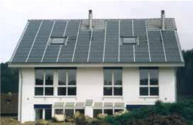
Abbildung 12: **Neubau Doppelfamilienhaus mit annähernd flächendeckender Anlage.** 10 kW Photovoltaikanlage. Die Dachfläche in Bäretswil (ZH) ist mit einer 10 kW Photovoltaikanlage gut genutzt. Die verbleibenden kleinen Flächen bei den Kaminen werfen jedoch ein paar technische und ästhetische Fragen auf. Quelle : Enecolo, Mönchaltorf
