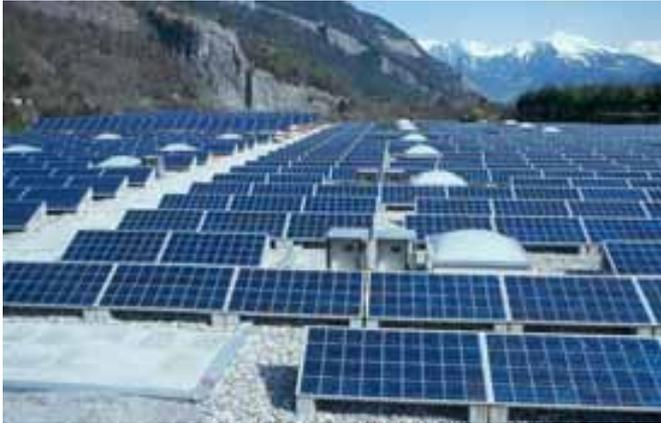
Abbildung 6: **Potenzial gut auf die Reihe gebracht.** Trotz der zahlreichen Aufbauten auf dem Flachdach ist mittels einer angepassten Anordnung die Installation einer grösseren Photovoltaikanlage möglich. Die Anlage befindet sich auf dem Büro- und Lagergebäude Gasser in Chur und weist eine Leistung von 90 kWp auf. Quelle: R. Hächler, Chur
