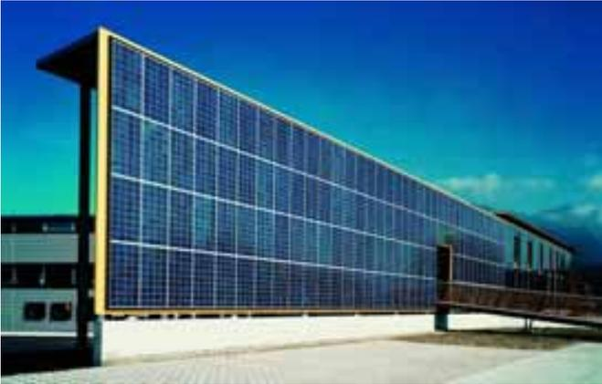
Abbildung 10: **Fassaden-Flächenpotenzial im Breitformat.** Eine langgezogene publikumswirksame Fassadenfläche ist beim Energiepark West in Satteins (Österreich) anzutreffen. Die Bauherrschaft setzt auf eine markante Fassade. Ein bedeutsames Fassadenflächenpotenzial findet sich bei Industrie- und Grosswohnbauten. Quelle : Stromaufwärts, Österreich
