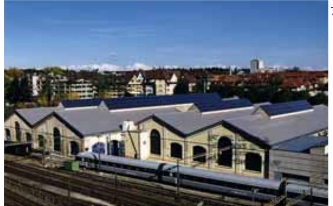
Abbildung 7: **Oberlichter doppelt genutzt.** Oberlichter können je nach Betrachtung als nutzbare oder nicht-nutzbare Flächen betrachtet werden. Das Lokdepot am Bahnhof Bern hat bei Renovationsarbeiten die „Aufbauten“ Oberlichter zur Solarstromerzeugung genutzt. Die semi-transparenten Module lassen ausreichend Licht in die Arbeitshalle. Quelle: Atlantis Energie, Bern
