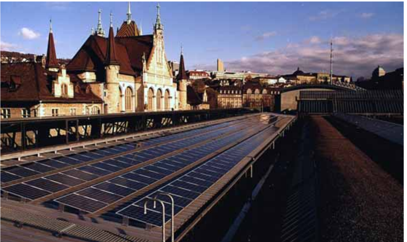
Abbildung 34: Leichte und robuste Last fürs Perrondach im Hauptbahnhof Zürich. Bedingt durch die leichte Bauweise des Perrondaches sind dessen statische Reserven äusserst gering. Die gesamte Solarstromanlage durfte lediglich 9 \text{ kg/m}^2 Zusatzlast auf das Dach aufbringen. Weiter musste die Wasserdichtigkeit des mit 7^\circ Grad geneigten Blechdaches gewährleistet werden. Trotzdem ist die mechanische Festigkeit und Stabilität bezüglich Wind- und Schneelast gesichert, und die gesamte Anlage hat ihre mechanische Feuerprobe in den Weihnachtsstürmen 1999 mit Erfolg absolviert. Quelle: energiebüro Zürich
