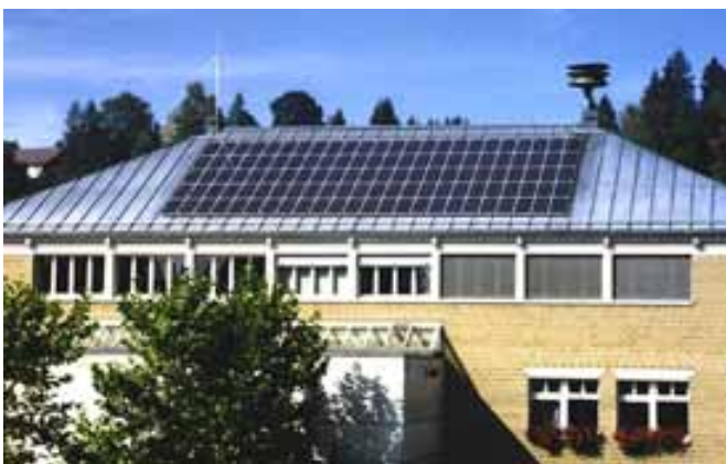
Abbildung 43: Dank Gönner Solaranlage auf dem Dach der Gemeindezentrum Rehetobels (AR). Rehetobels Gemeindezentrum zeigt auf dem Süddach 78 m 2 Solarzellen mit einer Leistung von 10,4 kW und einer durchschnittlichen Jahresproduktion von rund 10'000 kWh. Quelle: Appenzeller Energie - Vereinigung zur Förderung umweltfreundlicher Energien
