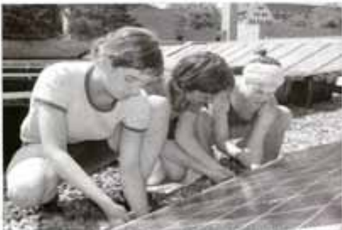
Sie trugen die Glasfenster auf dem Dach des Seminars (v.l.) Ursula Wenz, Nadin Bill und Nina Kappeler. Teil der Arbeit bei den Montagearbeiten.
