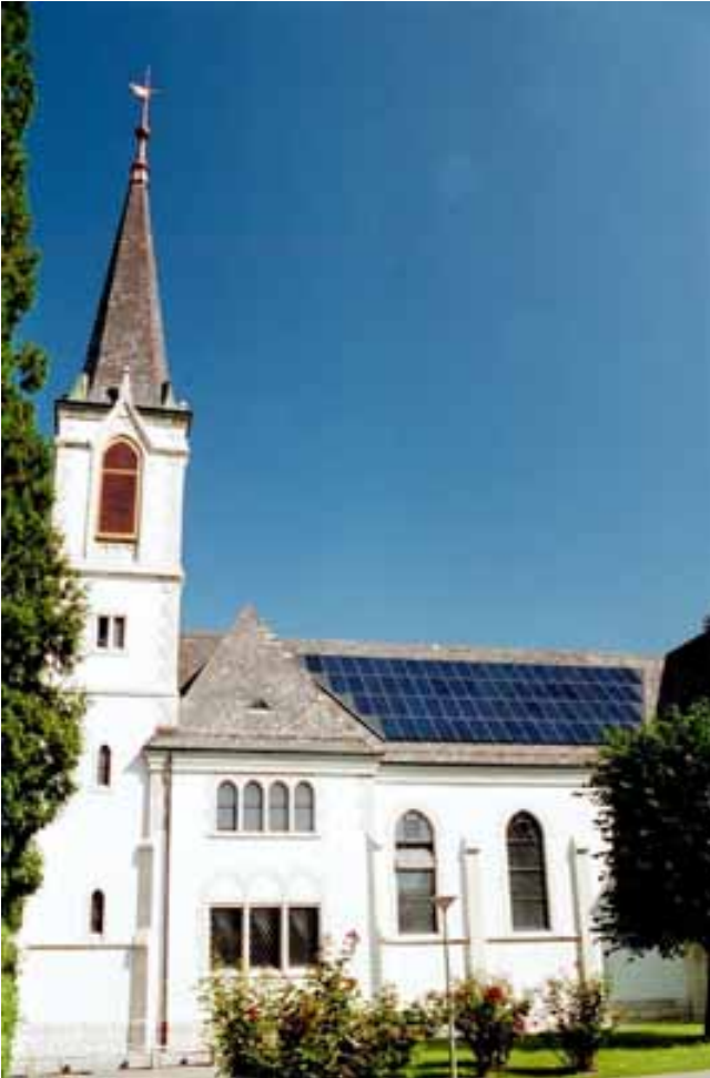
Abbildung 37: Respekt vor der Schöpfung und Architektur in Laufen (BL). Evangelisch-reformierte Kirche in Laufen (BL) mit der solargekrönten Photo- voltaikanlage (6 kW). Zur besseren ästhetischen Integration sind die Solarmodule mit einer anthrazit-farbigen Rückfolie versehen und zum seitlichen Abschluss sind dreieckige Blindmodule verwendet worden. Quelle: Holinger Solar, Buben- dorf
