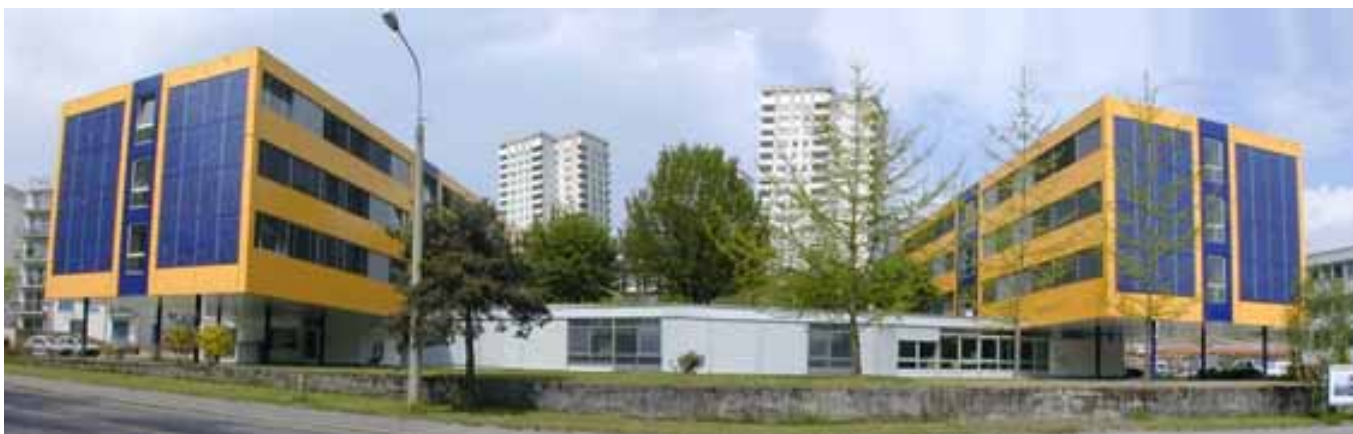
Abbildungen 21 bis 24: Auswahl an Solaranlagen in und um Lausanne. Hotelfachschule in Le Chalet-à-Gobet (VD) mit einer 38 kW Solaranlage. In der Mitte: Nestlé Forschungszentrum in Vers-chez-les-Blancs / Lausanne (VD) mit einer 22 kW Solaranlage sowie das Verwaltungsgebäude der Kantonalen Gebäudeversicherung (ECA) der Waadt in Lausanne (VD) mit einer 23 kW Solaranlage. Studierendenheim Rhodanie mit fassaden-integrierten Photovoltaikanlagen in farblich auffälliger und gefälliger Komposition. Quelle: Services Industriels de Lausanne
