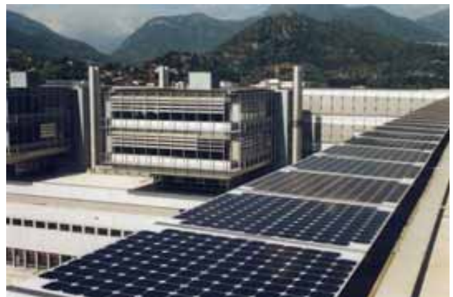
Abbildung 29: Neubau Bürogebäude in Manno (TI). Der Neubau des Bürogebäudes Suglio umfasste von Beginn an verschiedene Photovoltaiksysteme (Flachdach, Dachbrüstung und Fassade) im Gesamtenergiekonzept. Quelle: Enecolo, Mönchaltorf
