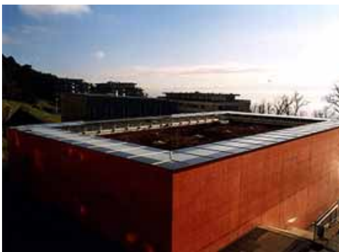
Abbildung 25: Minergie und Solarstrom gehen Hand in Hand. Die Turnhalle der Schule Acacias in Neuenburg ist im Minergiestandard erstellt. Auf dem Dach der Turnhalle steht eine multifunktionale Photovoltaikanlage von 69 m 2 Modulfläche. Die Anlage produziert jährlich rund 8500 kWh und funktioniert zudem als Sonnenschutz. Quelle: Service de l'urbanisme de la ville de Neuchâtel
