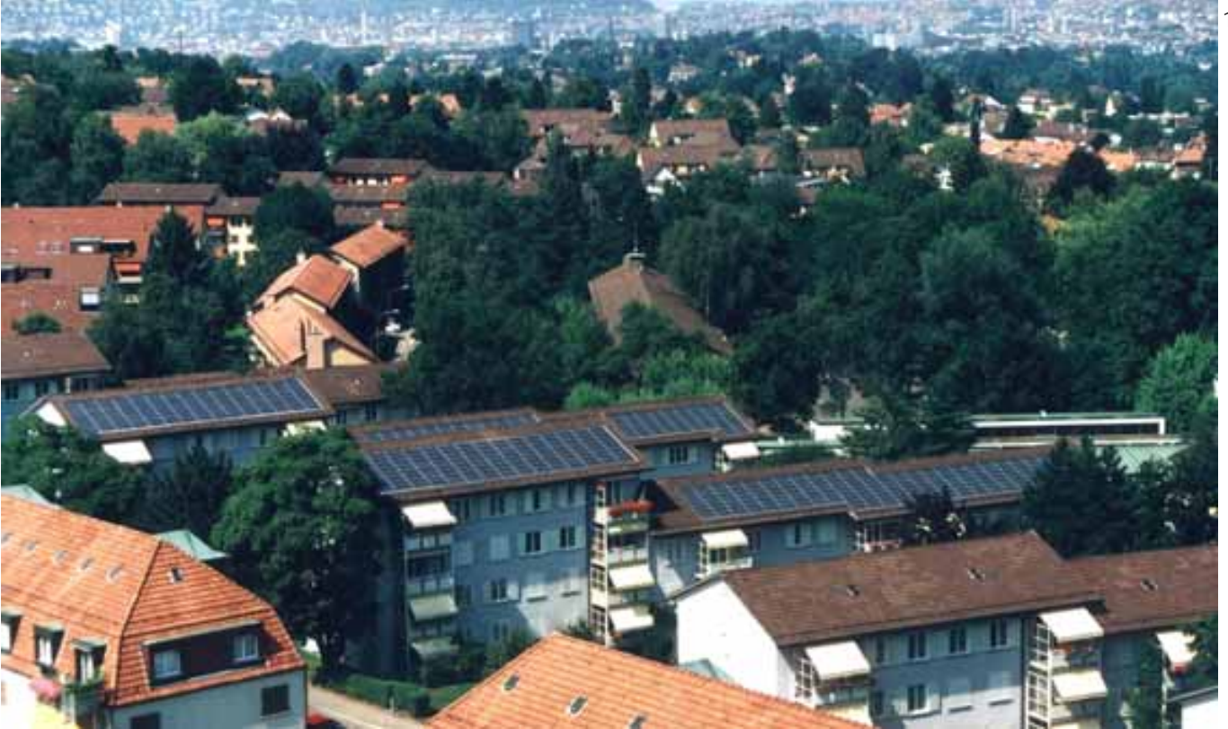
Abbildung 33: Renovation der Mehrfamilienhäuser mit Photovoltaik in Zürich. Die Baugenossenschaft hat bei den Renovationsarbeiten der Mehrfamilienhäuser mehrere Photovoltaikanlagen in die Schrägdächer integriert. Quelle: Enecolo, Mönchaltorf
