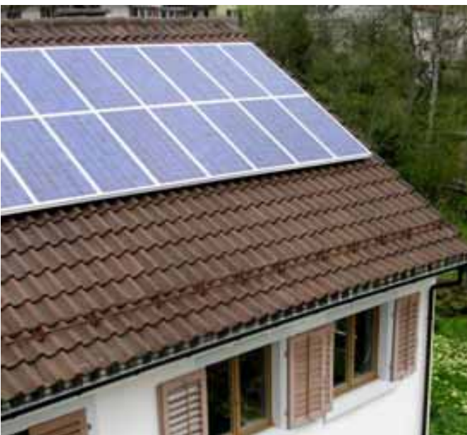
Abbildungen 11 und 12: Photovoltaikanlage auf Einfamilienhäusern in Zürich. Mit 3,3 kW hat die Installation auf dem Schrägdach eine typische Anlagengrösse der „Solaraktion“. Die Anlage auf dem Flachdach weist eine Leistung von 5,76 kW aus. Quelle : BE Netz, Luzern
