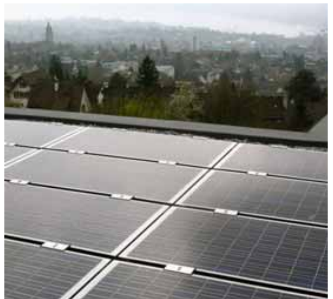
Abbildungen 11 und 12: Photovoltaikanlage auf Einfamilienhäusern in Zürich. Mit 3,3 kW hat die Installation auf dem Schrägdach eine typische Anlagengrösse der „Solaraktion“. Die Anlage auf dem Flachdach weist eine Leistung von 5,76 kW aus. Quelle : BE Netz, Luzern
