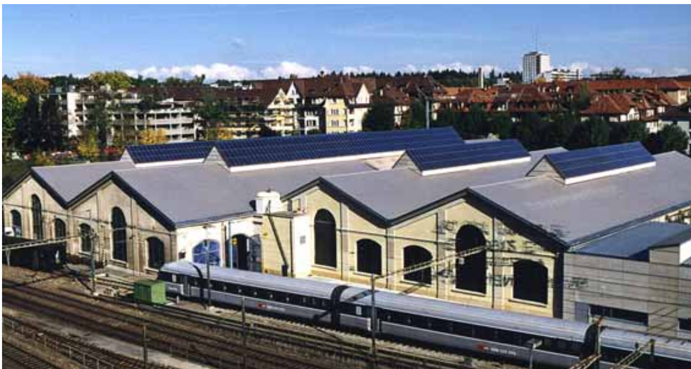
Abbildung 36: Solarstromanlage und Heimatschutz in Bern. Das Lokomotivdepot in Bern erhält natürliches Tageslicht durch die semi-transparenten Oberlichter und viel Lob vom Schweizer Heimatschutz für die gelungene Integration der Solartechnologie in den schützenswerten Bau. Quelle: NET, St. Ursen
