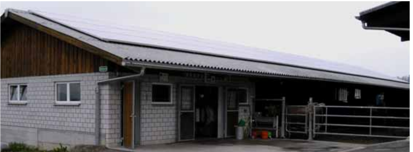
Abbildung 10: Photovoltaikanlage auf dem Laufstall in Zürich. Die grösste Anlage dieser Solaraktion erzielt mit 120 Solarmodulen eine Leistung von 19,8 kW. Quelle : BE Netz, Luzern
