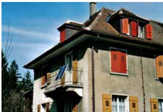
Abbildungen 17 bis 20: Solarkits . EPSILON Kits im Versorgungsgebiet der Services Industriels de Lausanne (SIL) und Freiburgischen Elektrizitätswerke (FEW), namentlich aufgestellt über den Storen in Jouxrens (VD), auf Garagendach in Belfaux, angehängt an Fassade in Düdingen und aufgehängt am Balkongeländer in Freiburg i.Ue. Quelle: Services Industriels de Lausanne / M. Gutschner, Freiburg i.Ue.
