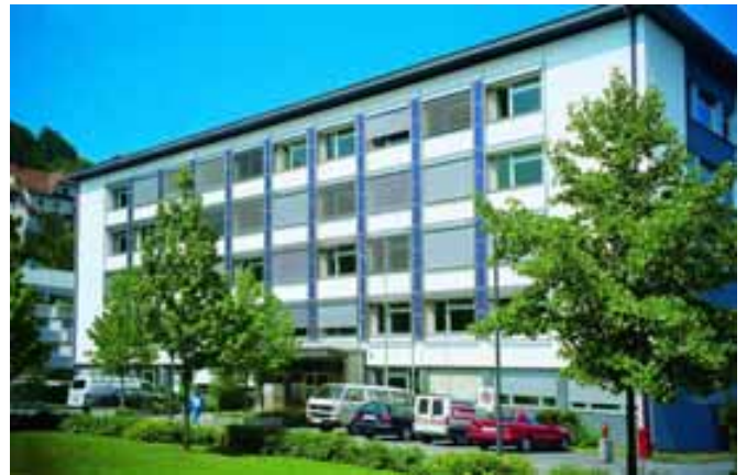
Abbildung 31: Ästhetischer Nutzen für das Vorarlberger Landeshochbauamt. Die Photovoltaik als architektonisches Element der Fläche: Der in die Breite strebende Bau wirkt dank der photovoltaischen Elemente feingliederiger. Die fassaden-integrierte Photovoltaikanlage hat eine Leistung von 5,3 kW. Quelle: Stromaufwärts, Österreich
