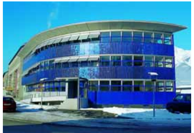
Abbildung 2: Publikumswirksame Fassade der lokalen Stadtwerke in Hall (A). Die Photovoltaikanlage in der Fassade der Stadtwerke im tirolerischen Hall (A) erzeugt nicht nur Strom, sondern trägt dank erfolgreicher Publizität auch zu einem guten Image bei. Quelle: Stromaufwärts, Österreich
