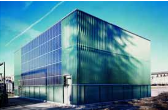
Abbildung 30: Technischer Nutzen für das Umspannwerk. Durch die luft- und wasserdichte Einbettung der Photovoltaikmodule in die Glasfassade konnten die Vorarlberger Kraftwerke auf eine Klimatisierung des Gebäudes verzichten. Quelle: Stromaufwärts, Österreich
