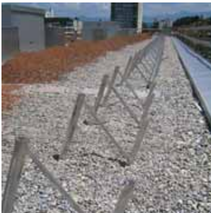
Abbildungen 16 bis 21: Montage der Tragstruktur und Module in Pfäffikon (SZ). Schritt um Schritt, Bild um Bild die Installation der Photovoltaikanlage (32 kW) auf dem Grünflachdach des Mehrfamilienhauses Huob der Swiss Re in Pfäffikon (SZ) mit Platten, Kies, Montage der Stützen, Module und Klammern. Quelle: Enecolo, Mönchaltorf
