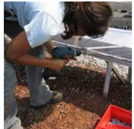
Abbildungen 16 bis 21: Montage der Tragstruktur und Module in Pfäffikon (SZ). Schritt um Schritt, Bild um Bild die Installation der Photovoltaikanlage (32 kW) auf dem Grünflachdach des Mehrfamilienhauses Huob der Swiss Re in Pfäffikon (SZ) mit Platten, Kies, Montage der Stützen, Module und Klammern. Quelle: Enecolo, Mönchaltorf
