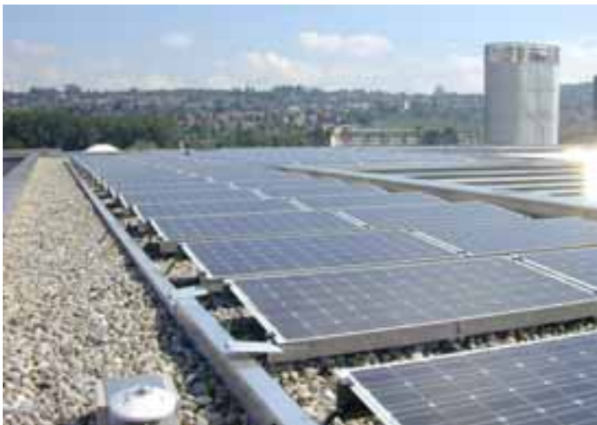
Abbildung 1: Design und Detail am Gebäude der IBM in Zürich. Die Photovoltaikanlage ist Teil eines umfassenden Bauprojekts mit Anspruch auf hohe Qualität. Die hohen architektonisch-ästhetischen Ansprüche erforderten eine spezielle Einpassung der Solaranlage ins Flachdach, insbesondere die Neigung der Solarmodule musste möglichst tief gehalten werden. Quelle: NET, St.Ursen
