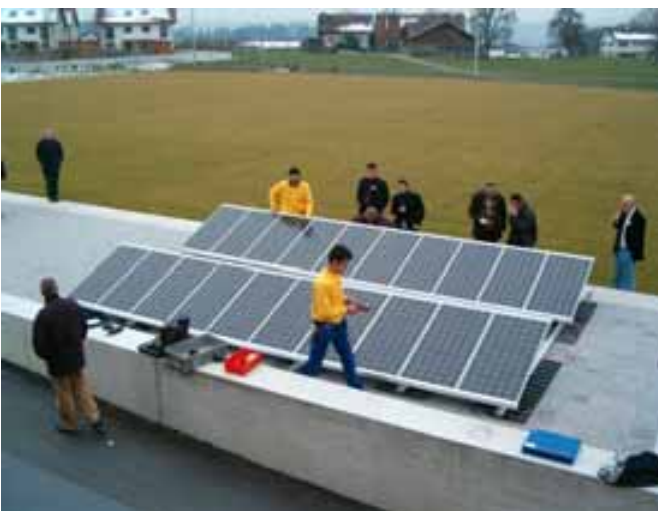
Abbildungen 22 bis 27: Photovoltaikanlage in 32 Minuten montiert in Hünenberg (ZG). Anlässlich der Einweihung der 27 kW Anlage auf dem Dach des Freizeit- und Sportgebäudes Ehret in Hünenberg (ZG) demonstrierte ein Team die Erstellung einer 2,2 kW Anlage mit dem neu entwickelten Montagesystem AluStand. 32 Minuten nach Start der Demonstration floss der Strom ins Netz. Quellen: NET, St. Ursen; U. Bühler, Cham
