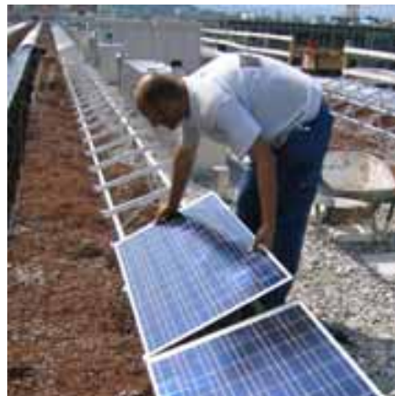
Abbildungen 16 bis 21: Montage der Tragstruktur und Module in Pfäffikon (SZ). Schritt um Schritt, Bild um Bild die Installation der Photovoltaikanlage (32 kW) auf dem Grünflachdach des Mehrfamilienhauses Huob der Swiss Re in Pfäffikon (SZ) mit Platten, Kies, Montage der Stützen, Module und Klammern. Quelle: Enecolo, Mönchaltorf
