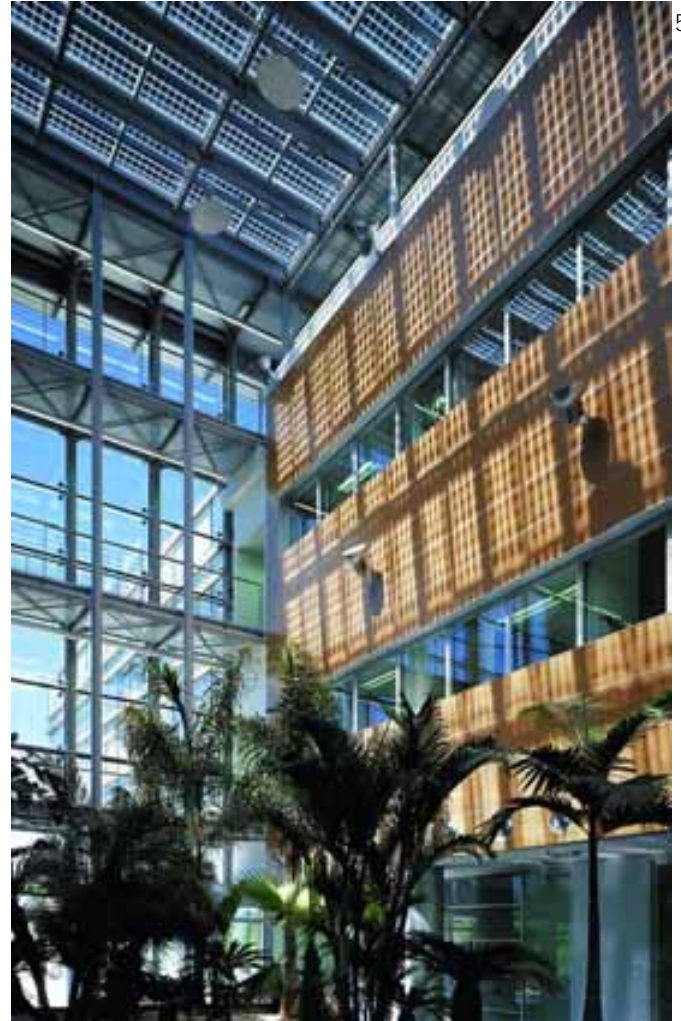
Abbildung 6: Lichtdurchflutete Hallen bei STMicroelectronics in Plan-les-Ouates (GE) . Die semitransparente Photovoltaikanlage produziert jährlich 25'000 kWh Solarstrom und trägt zu einem angenehmen Ambiente bei. Quelle: AMA Group / Engeco Synergies, Italien
