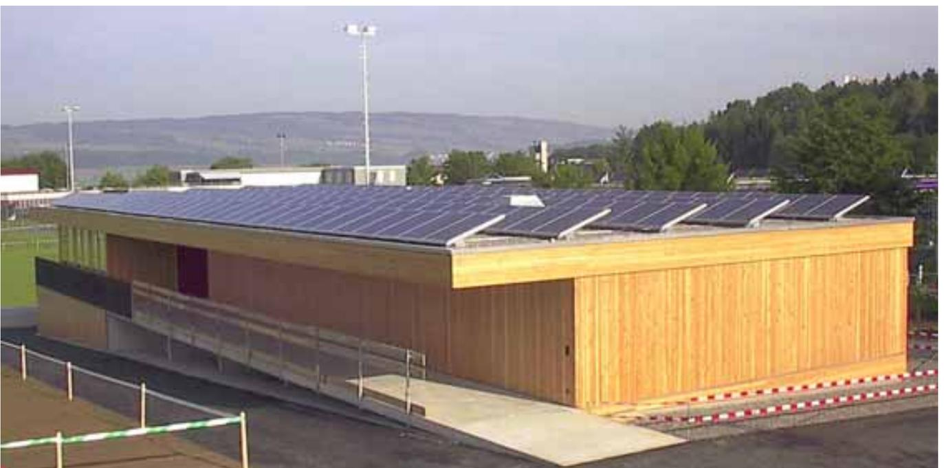
Abbildung 24: **Sport- und Freizeitanlage Ehret in Hünenberg (ZG).** Die Elektro-Genossenschaft Hünenberg (EGH), die rund 60% des Gemeindegebiets mit Elektrizität versorgt, produziert hier Solarstrom für alle StrombezügerInnen der Genossenschaft. Quelle: EGH, Hünenberg
