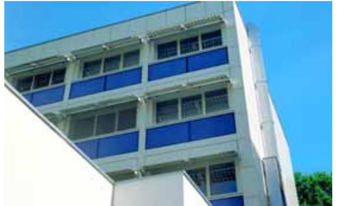
Abbildung 34: **Verwaltungsgebäude der Gastro Ticino in Lugano mit photovoltaischen Beschattungselementen.** Die Solarzellen sind auf beweglichen Platten montiert. Die automatisch gesteuerte Ausrichtung gewährleistet zwei Funktionen: Wirkung als Sonnenblenden auf den Fensterflächen und energieertragsoptimale Orientierung der Zellen. Die Fassade weist auch Solarkollektoren (in blau) auf. Quelle: B. Gerber, SSES, Bern
