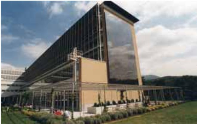
Abbildung 33: **Bürogebäude in Manno (TI) mit Photovoltaik im Gesamtenergiekonzept.** Der Neubau der UBS wurde in ökologischer und energetischer Hinsicht beispielhaft erstellt. Die Photovoltaikanlage umfasst 183 kW verteilt auf verschiedenen Flächen der Gebäudehülle: 102 kW auf dem Flachdach, 47 kW in der Dachbrüstung (auch als Sonnenschutz) und 34 kW in zwei Südfassaden. Quelle: Enecolo, Monchaltorf
