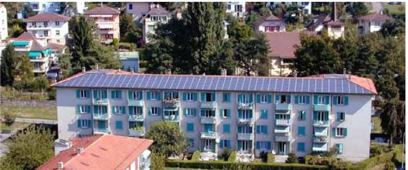
Abbildung 30: **Mehrfamilienhaus in Lausanne.** Die Solaranlage (38 kW) leistet einen Beitrag zur Nachhaltigkeit und vermittelt zugleich einen Hauch Exklusivität - Argumente, die bei (potenziellen) MieterInnen zählen. Der Solarstrom wird an der Solarstrombörse der Services Industriels de Lausanne (SIL) gehandelt. Die Stadt Lausanne hat die Installation zusätzlich finanziell unterstützt. Bau und Betrieb der Anlage erfolgen durch Contracting mit Edisun Power. Quelle: NET, St. Ursen
