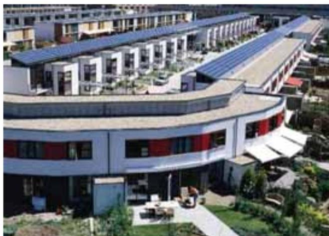
Abbildungen 64 bis 66: **Solarsiedlungen in Amersfoort (NL)**. Beim Neubau der Siedlung Nieuwland in der niederländischen Stadt Amersfoort sind mehrere hundert Gebäude mit einer Photovoltaikanlage ausgestattet worden. Das Projekt hat alle relevanten Akteure (Behörden, Investoren, Stromversorger, zukünftige Gebäudeeigentümer, etc.) zusammengebracht. Insgesamt ist eine Leistung von 1,35 MW installiert. Quelle: Ecofys Niederlande
