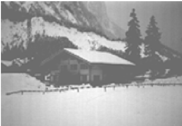
Einpassung ins Dorfbild. Kleinwasserkraftwerk Kandersteg. (Bild: LWK AG)
