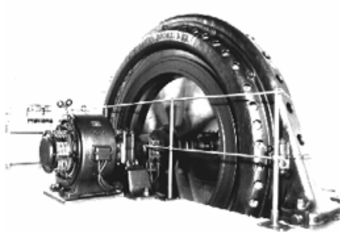
Kleinwasserkraftwerk Stropfel Untersiggenthal. (Bild: A. Phillipe, Turgi)
