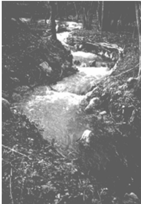
Umgehungsgerinne beim Kleinwasserkraftwerk Sigismühle Seon.
