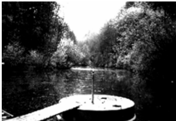
Wasserfassung und Stauraum beim Kleinwasserkraftwerk Guggenloch Lütisburg (Wasserfassung im Vordergrund).
