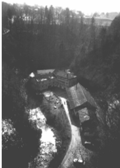
Energieversorgung des Gewerbes durch Kleinwasserkraftwerke (Guggenloch Lütisburg).
