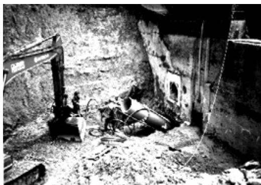
Verlegung der Druckleitung für das Kleinwasserkraftwerk Guggenloch Lütisburg.
