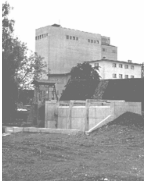
Kleinwasserkraftwerk Obermühle Baar.
