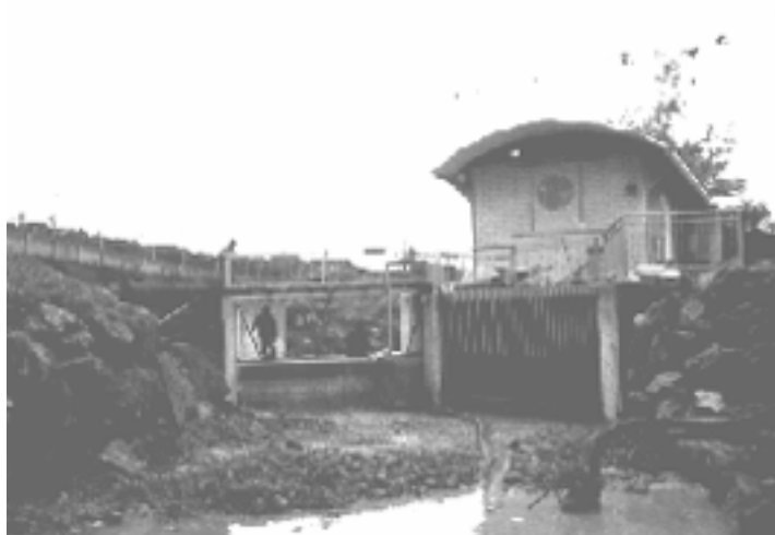
Bauarbeiten beim Kleinwasserkraftwerk Mülibach Burgdorf.
