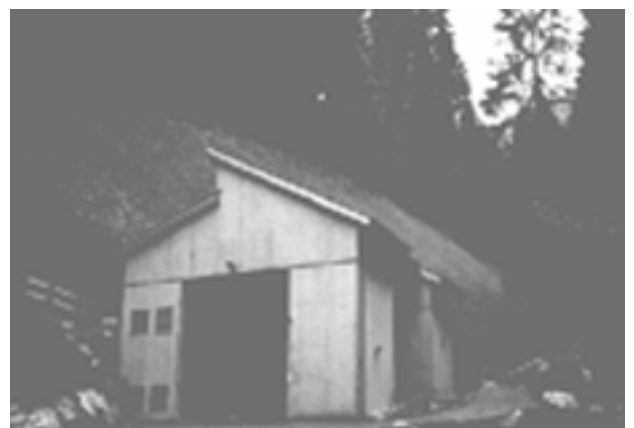
Neubau. Kleinwasserkraftwerk Klusi Erlenbach. (Bild: BKW FMB Energie AG)
