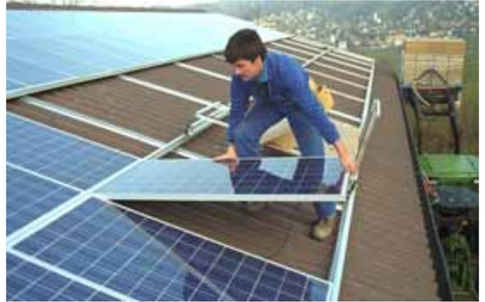
Abbildung 121: **Aufbau- oder Aufdachlösung.** Quelle : BE Netz, Luzern
