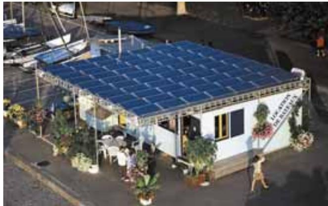
Abbildung 29: **La Rade Solaire in Genf.** Die Anlage „Les Corsaires“ gehört zur Rade Solaire, die entlang des städtischen Seeufers verschiedene photovoltaische Anwendungen zeigt. Die abgebildete Anlage speist mehrere Solarboote sowie eine solarbetriebene Touristenbahn. Quelle: ScanE, Genf
