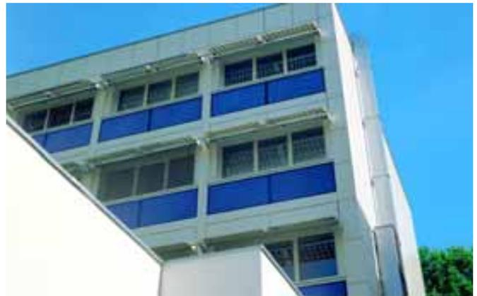
Abbildung 49: **Verwaltungsgebäude der Gastro Ticino in Lugano mit photovoltaischen Beschattungselementen.** Die Solarzellen sind auf beweglichen Platten montiert. Die automatisch gesteuerte Ausrichtung gewährleistet zwei Funktionen: Wirkung als Sonnenblenden auf den Fensterflächen und energieertragsoptimale Orientierung der Zellen. Die Fassade weist auch Solarkollektoren (in blau) auf. Quelle: B. Gerber, SSES, Bern
