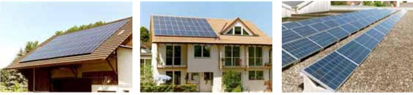
Abbildungen 84 bis 86: Solaranlagen des Thurgauer Solarstrom-Pools. Beispiele sind die Schrägdach Photovoltaikanlagen in Amriswil (TG) mit 11 kW und in Frauenfeld (TG) mit 4,8 kW sowie die Flachdach Photovoltaikanlage in Kreuzlingen (TG) mit 10,8 kW Leistung. Quelle: Solarstrom-Pool Thurgau
