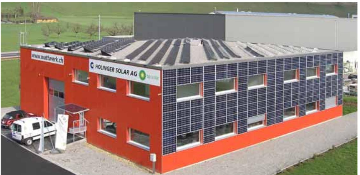
Abbildung 39: **WATTWERK – das erste Plus-Energie-Gewerbehaus in der Welt steht in Bubendorf (BL)**. Das Gebäude produziert mehr Energie als die BenutzerInnen für Heizung, Warmwasser, Licht, Elektromobile und EDV verbrauchen. Diese Leistung wird ermöglicht durch Dämmung (Passivhaus / Minergie-Technik), Effizienz sowie Photovoltaikanlage für Stromgewinnung. Die Anlage erzeugt jähr-
