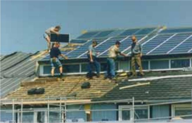
Abbildung 120: **Einbau- oder Indachlösung.** Quelle: Ecofys Niederlande
