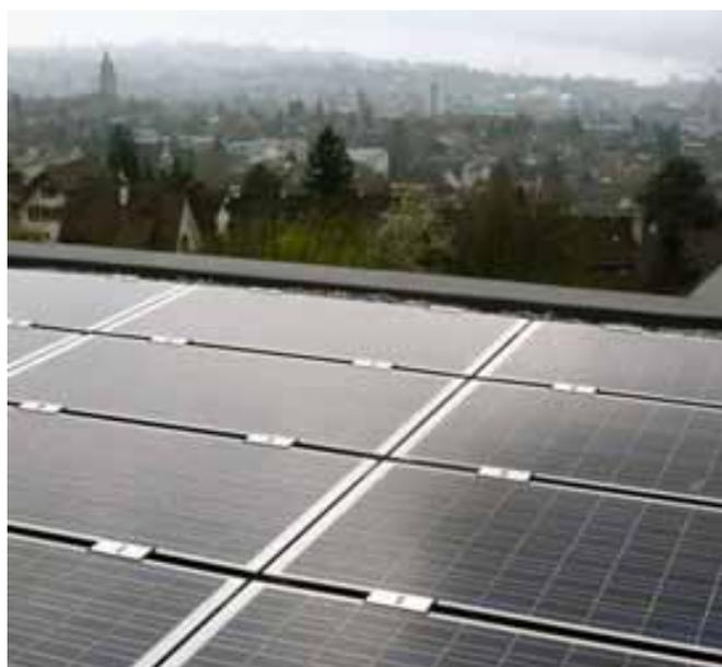
Abbildung 96: **Photovoltaikanlage auf dem Flachdach eines Einfamilienhauses in Zürich.** Die Anlage weist eine Leistung von 5,76 kW aus. Quelle : BE Netz, Luzern
