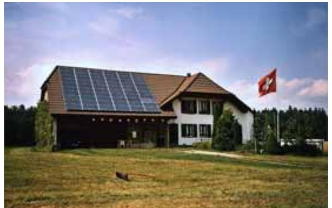
Abbildung 123: **Teilflächige Aufdachlösung.** Das Gebäude in Lyss (BE) beherbergt eine Anlage in Aufdachlösung – unterstützt im Rahmen des „Solarfrankens“ (CHF 1.00 pro solare kWh, garantiert während 10 Jahren) der ehem. Gemeindebetriebe Lyss. Quelle: M. Gutschner, Freiburg i. Ue.
