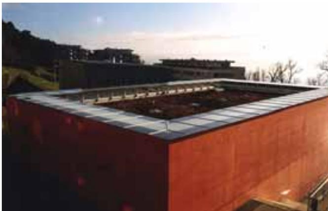
Abbildung 112: **Minergie und Solarstrom in Neuenburg.** Die Turnhalle der Schule Acacias im Minergiestandard hat eine multifunktionale Photovoltaikanlage von 69 m<sup>2</sup> Modulfläche auf ihrem Dach: sie erzeugt Strom und funktioniert zudem als Sonnenschutz. Quelle: Service de l'urbanisme de la ville de Neuchâtel
