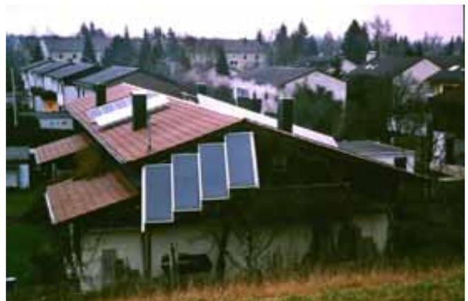
Abbildung 127: *“Integration” – kritisches Beispiel aus Krailling (D)*. Das gute gemeinte Engagement der HausbewohnerInnen ist spürbar. Dennoch stellt sich die Frage, ob die Kollektoren und Module nicht ästhetischer integriert werden können. Rechtfertigt der energetische Mehrertrag durch erhöhte Neigung der solaraktiven Flächen diese Aufständerei? Quelle: M. Gutschner, Freiburg i.Ue.
