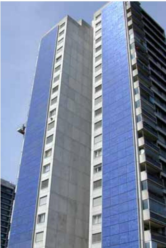
Abbildung 35: **Europas größtes fassaden-integriertes Solarkraftwerk steht in Bern Wittgkofen.** Mit einer Leistung von 80 kW produziert die Anlage Solarstrom für Energie Wasser Bern (ewb). Quelle: NET, St. Ursen
