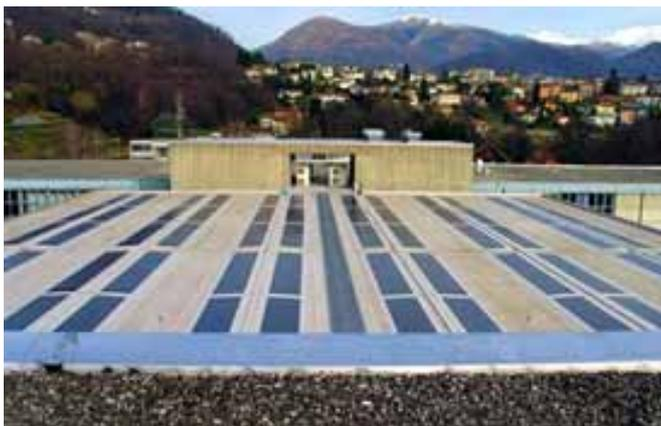
Abbildungen 54 und 55: **Innovative Integrationslösungen aus Schweizer Produktion auf den Dächern des Centro Professionale in Trevano (TI) und des Flumroc-Fabrikgebäudes in Flums (SG).** Beim Sarnasol Photovoltaik System (Beispiel in Trevano) sind die flexiblen Photovoltaik-Lamine mit der
