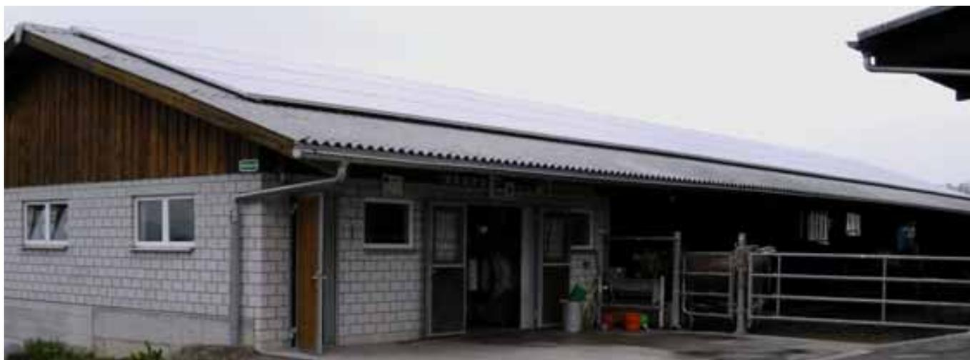
Abbildung 94: **Photovoltaikanlage auf dem Laufstall in Zürich.** Die grösste Anlage dieser Solaraktion erzielt mit 120 Solarmodulen eine Leistung von 19,8 kW. Quelle : BE Netz, Luzern
