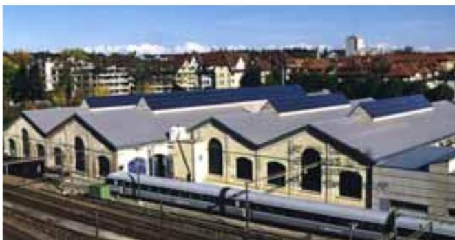
Abbildungen 78 und 79: **Solarstromanlagen in Bern.** Oberlicht-integrierte Anlage auf dem Lokomotivdepot und Sheddach-integrierte Anlage des Gewerdeparks Felsenau produzieren jährlich rund 50'000 respektive 225'000 kWh
