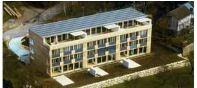
Abbildung 38: **Photovoltaik für Nullheizenergiehaus in Zürich Höggen**. Das Mehrfamilienhaus ist ein Nullheizenergiehaus: Der Solarstrom versorgt Wärmepumpe für Warmwasser und Heizung. Quelle: Beat Kämpfen, René Naef, Zürich
