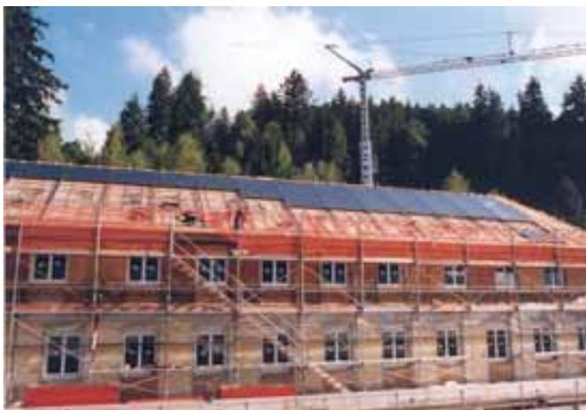
Abbildungen 80 und 81: **Solarstrom in Zug.** Installation der Solaranlage auf dem Dach der Höhenklinik Adelheid, Unterägeri (ZG). Die Wasserwerke Zug (WWZ) betreiben diese Anlage und verkaufen den Solarstrom direkt an ihre
