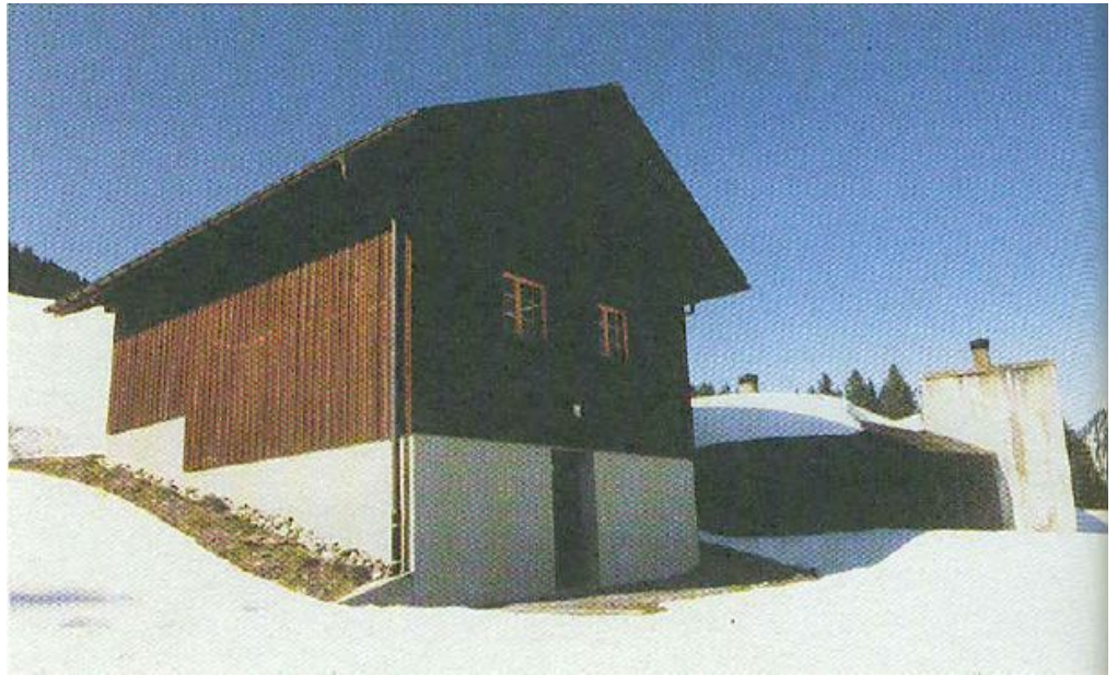
Maschinenhaus, angepasst an die Umgebung Salle des machines, adaptée à l'environnement
