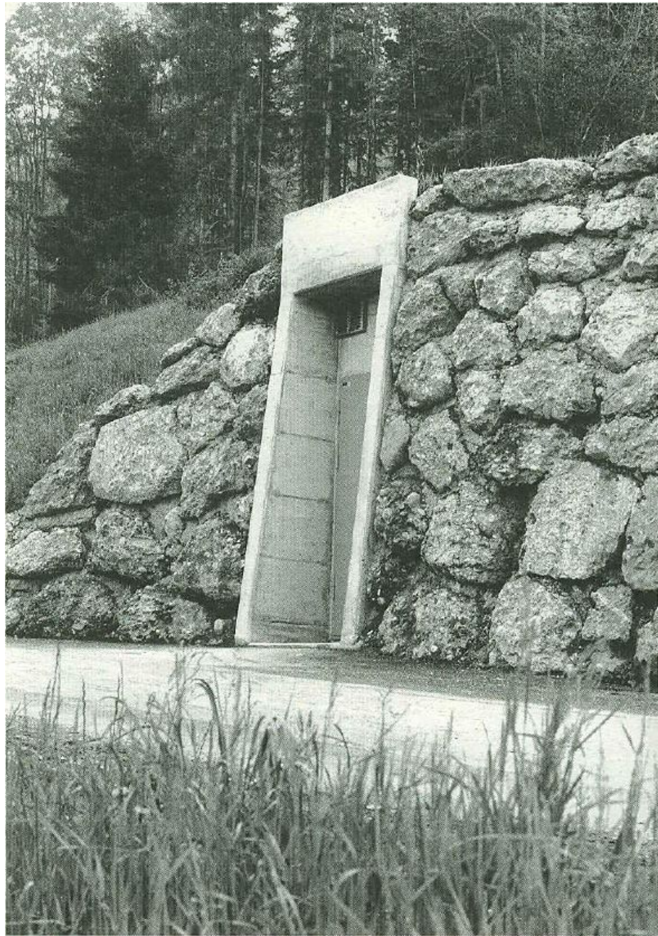
Eingang zum neuen Turbinenhaus Waldstrasse
