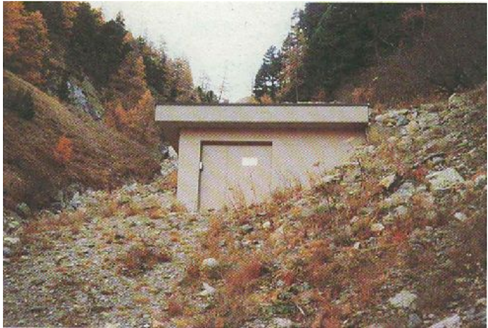
Aussenansicht Turbinengebäude / Vue extérieure du bâtiment des turbines
