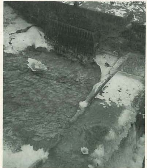
Die seitliche Fassung mit den Grobrechen Le captage latéral avec la grille grossière
