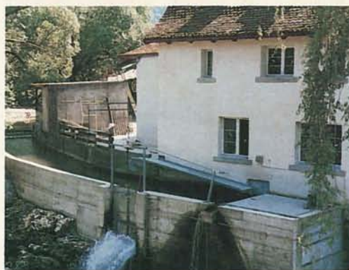
...et après rénovation ...und nach der Modernisierung
