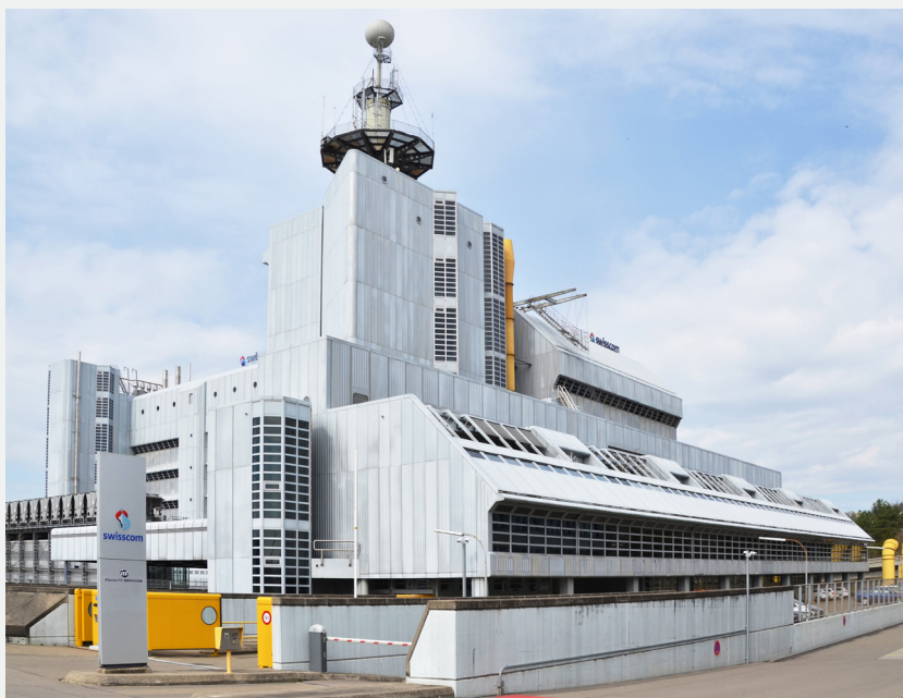
Die Studie CEST-DC hat verschiedene Nachhaltigkeitsaspekte von Rechenzentren untersucht. Im Bild: Das Rechenzentrum von Swisscom in Zürich-Herdern, das seit 2012 Wärme an einen regionalen Wärmeverbund liefert. Foto: Shutterstock
