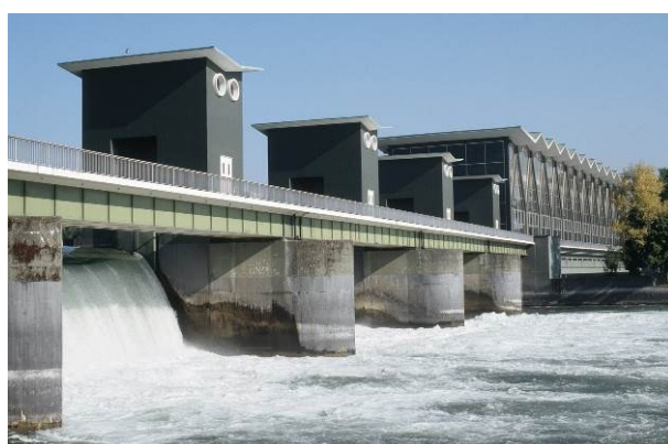
Flusskraftwerk Birsfelden (BL)
