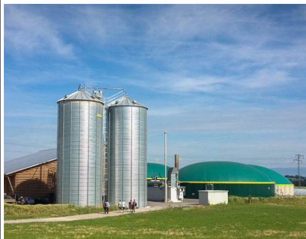
Biogasanlage Düdingen (FR)
