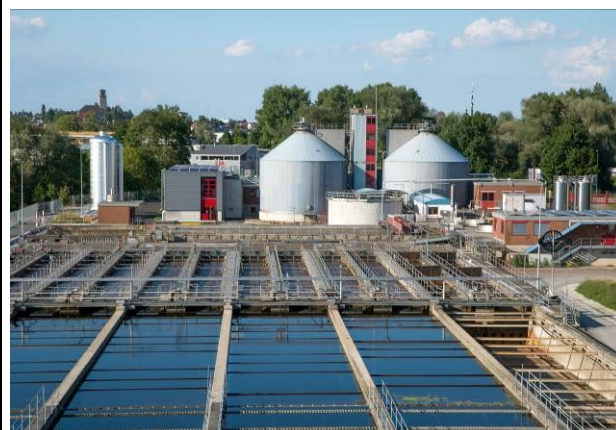
Kläranlage Morgental (SG)
