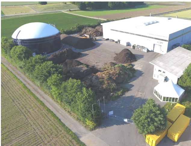
Kompostieranlage Oensingen © www.kompostieranlage-oensingen.ch
