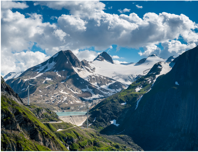
Das Wasserkraftwerk Aegina-Altstafel unterhalb des Griessees (Bild) unweit des Nufenenpasses wurde mit (bestehenden) Windkraftwerken, einer (noch zu bauenden) Solaranlage und (potentiellen) Batterien unterschiedlicher Grösse zu einem «virtuellen» Kraftwerk kombiniert. Foto: Shutterstock
