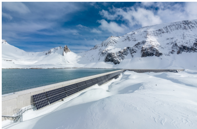
Auch eine Form der Hybridisierung: Seit August 2022 liefert eine Solaranlage auf der Staumauer des Muttsees in den Glarner Alpen gut 3 Mio. kWh pro Jahr. Vergleichsweise hoch ist der Ertrag in den Wintermonaten. Foto: Axpo
