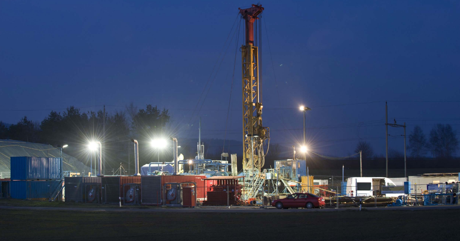
Der Bohrplatz der ersten Bohrung (SLA-1) neben der Grob Gemüse AG in der Thurgauer Gemeinde Schlattingen (Bildquelle: Nagra).
