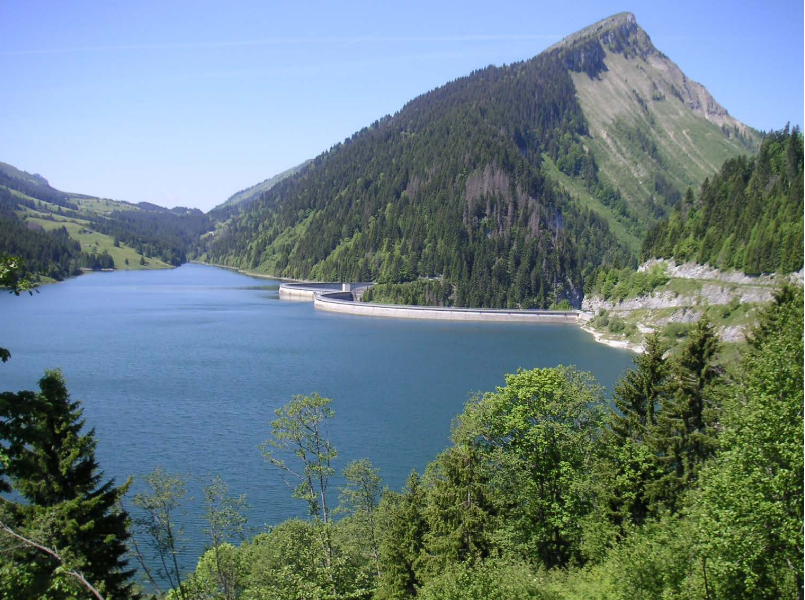
Ansicht des Stausees des Speicherkraftwerks «Hongrin-Léman» in den Waadtländer Alpen. Die Anlage nutzt die Höhendifferenz zwischen dem Lac de l'Hongrin (1255 m ü. M.) und dem Genfersee (377 m ü. M.) zur Produktion sowie Speicherung von Strom (Bildquelle: Commons Wikimedia, Gcottenc, CC BY-SA 2.5).
