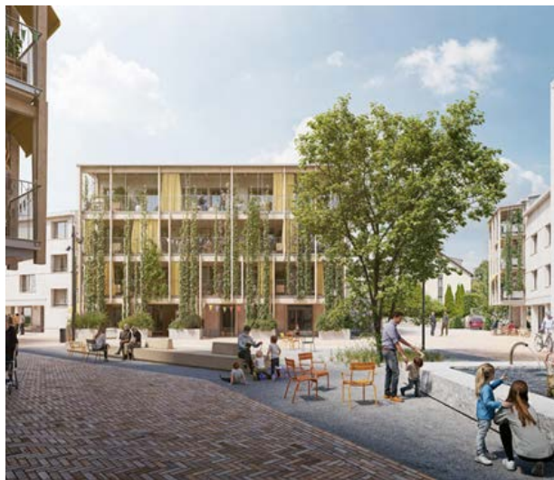
Wohnsiedlung Burkwil in Meilen: Burkwil bietet hochwertige, hindernisfreie Wohnungen für rund 160 Menschen. Die sechs Neubauten wurden möglichst emissionsarm mit Vollholz, Lehm und zementreduziertem Beton gebaut (Bildquelle: © Tend AG).
