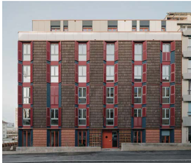
Wohn- und Gewerbegebäude LysP8 in Basel: Innovativer und flächeneffizienter Neubau mit maximalem Anteil wiederverwendeter Bauteile für 27 Kleinwohnungen sowie Gewerbe im Erdgeschoss. Hinterlüftete Reuse-Fassade mit Ziegeleindeckung (Bildquelle: Loeliger Strub Architektur, © Federico Farinatti).
