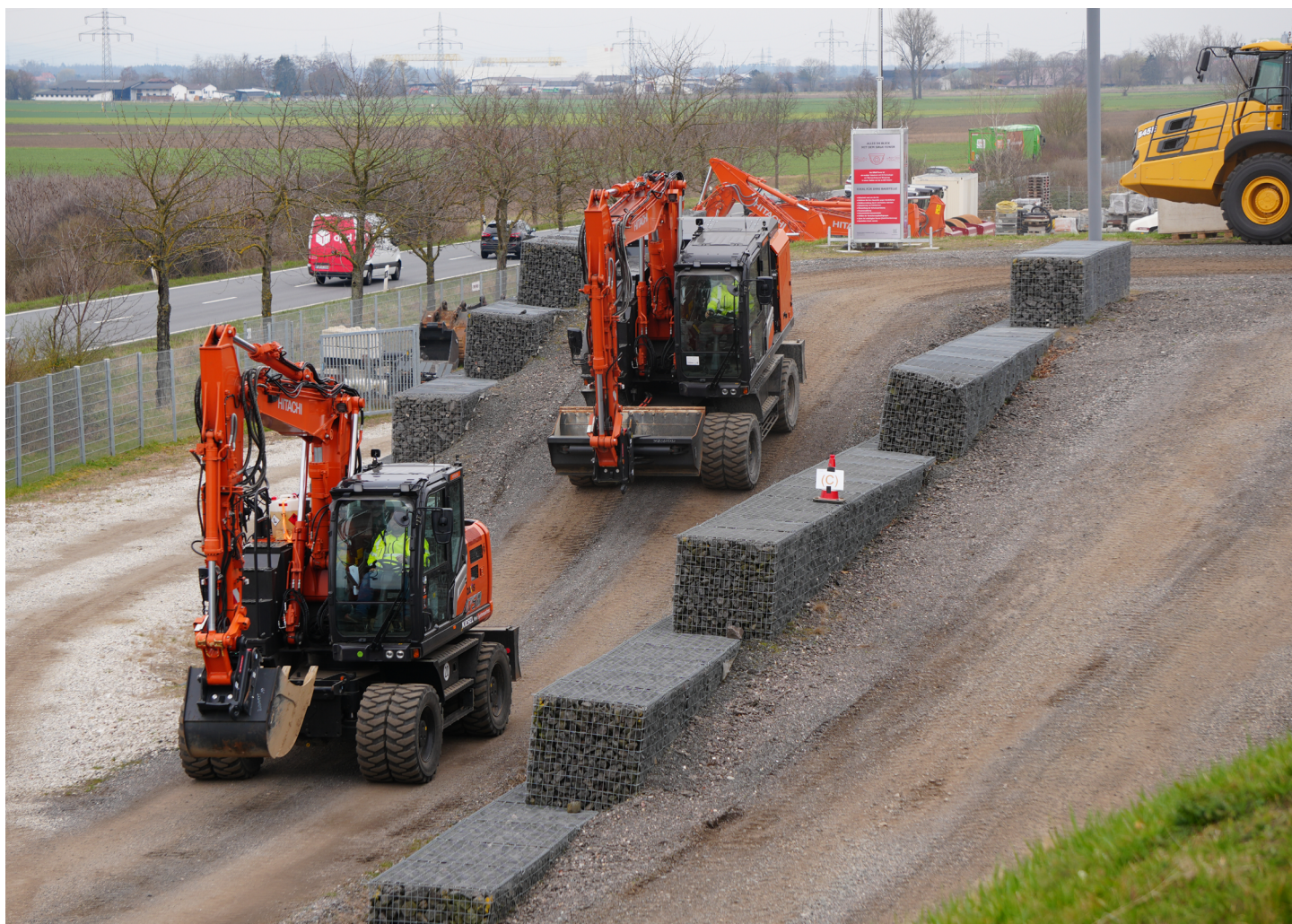
Einsatz des Diesel-betriebenen Mobilbaggers (vorne) und des elektrifizierten Prototyps (hinten) auf einem Testgelände. Bei Versuchsfahrten wurde unter anderem der Energieverbrauch gemessen. Foto: BFE-Schlussbericht
