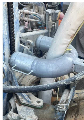
Auffüllen der coaxialen textilen Erdsonde von TTS INOVA AG
