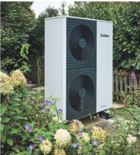
Teil der energetischen Erneuerungen: die Luft-Wasser-Wärmepumpe.
