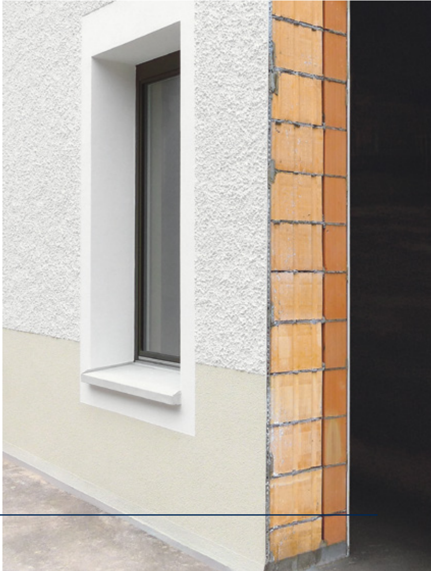
So wird es gemacht: KISMUR-Fassadenaufbau auf dem Ziegelei-Areal.
