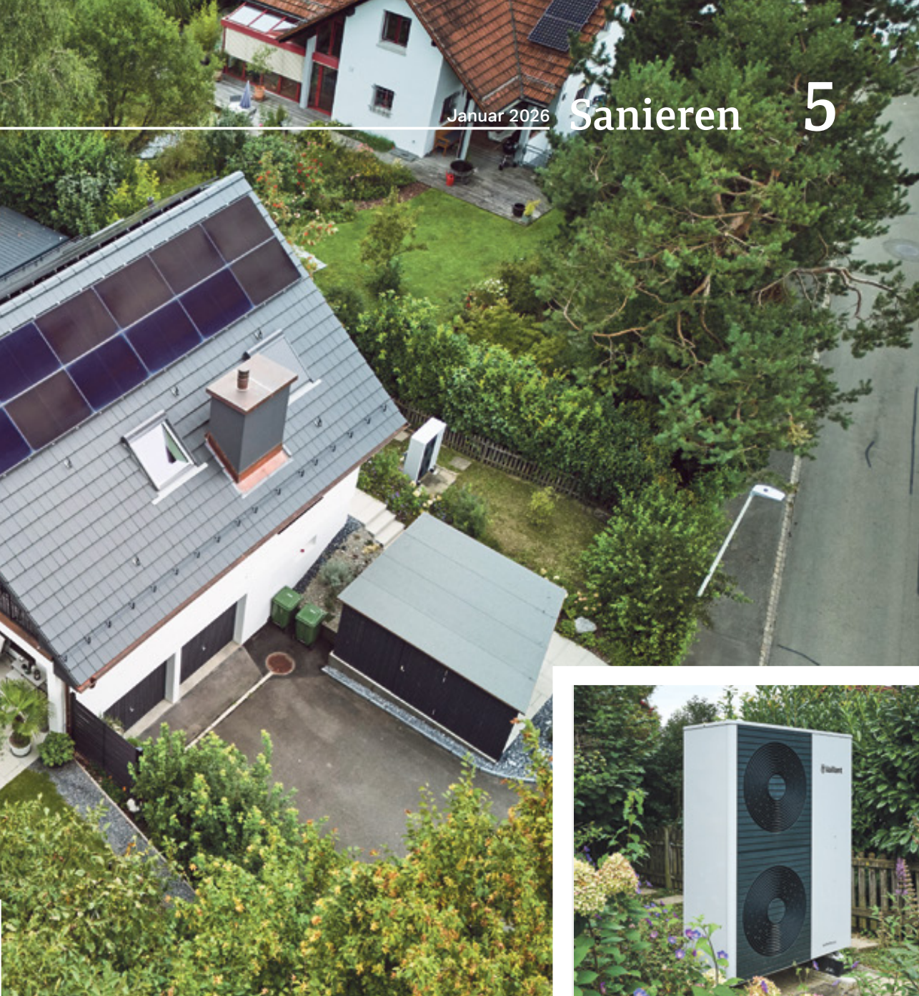
Erst liessen die Colluras das Dach ihres Hauses sanieren – danach statteten sie es mit einer 10,4-kWp-Photovoltaikanlage aus.
