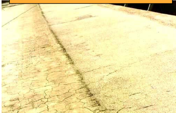
Staudamm Barrage en remblai
