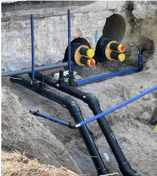
Bild 4.8 Sanierung und Modernisierung Quartiersgelände, Schul- und Sportzentrum Schifferstadt DE KMR-Doppelrohr und PE-Rohr (GEROtec ANERGIE Typ 1 - PE100-RC) in konventioneller und grabenloser Verlegung Quelle: Gerodur MPM Kunststoffverarbeitung GmbH & Co. KG
