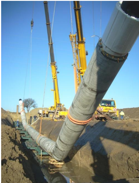
Bild 4.29 Vorgefertigter Düker wird in die Dükerrinne gehoben um danach auf Rollen in das Flussbett geschoben zu werden [135].
