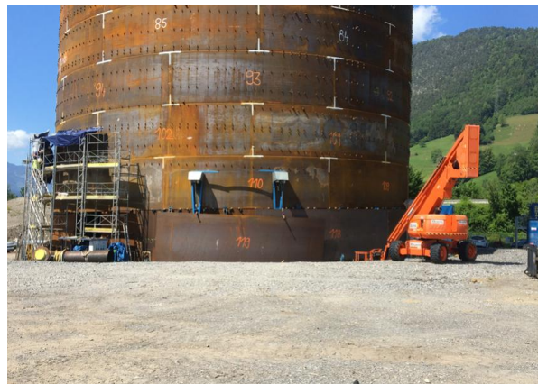
Bild 2.55 Speicher der Agro Energie Schwyz Ag im Bau (28'000 m 3 , [85]).
