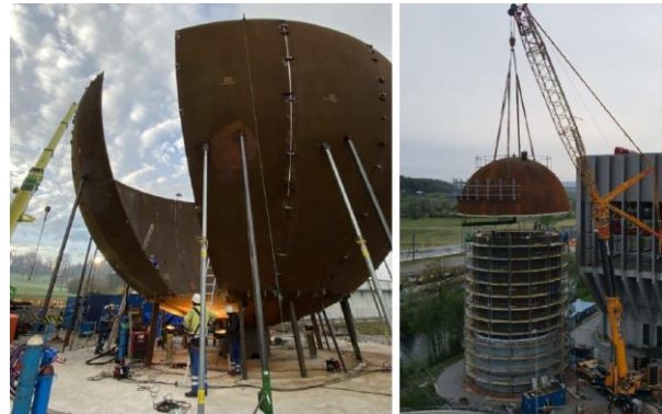
Bild 2.57 Wärmespeicher der Renergia im Bau (5'000 m 3 , [80]).
