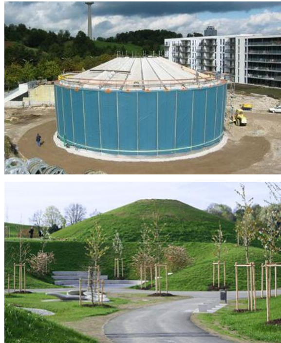
Bild 2.58 6'000 m 3 Speicher der Stadtwerke München in München-Ackermannbogen im Bau (oben) und nach Fertigstellung (unten) [90].
