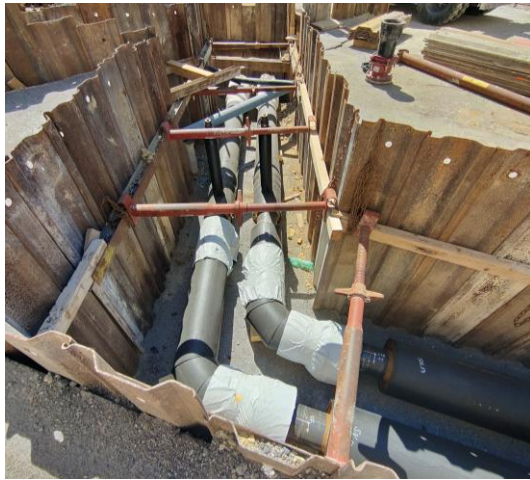
Bild 4.27 Fernwärmerohre im gespiessten Graben.
