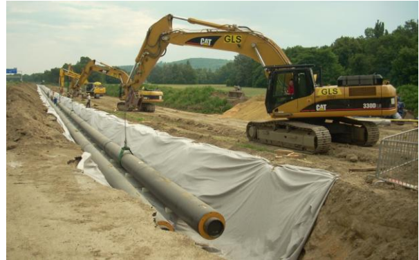
Bild 4.30 Pipeline-Verlegung [135].
