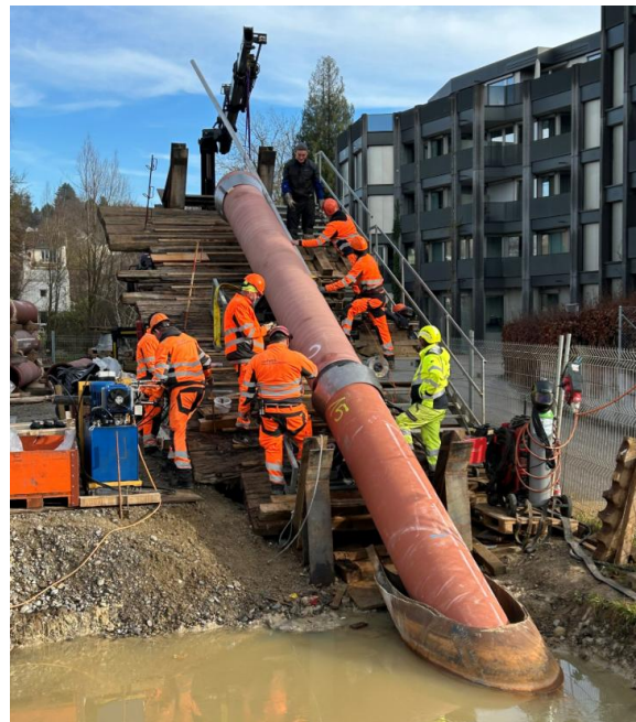
Bild 4.9 Verlegung duktiler Gussrohre DN 600 in Spülbohrtechnik zur Versorgung des Gesundheitsclusters Lengg in Zürich aus dem Zürichsee [124].
