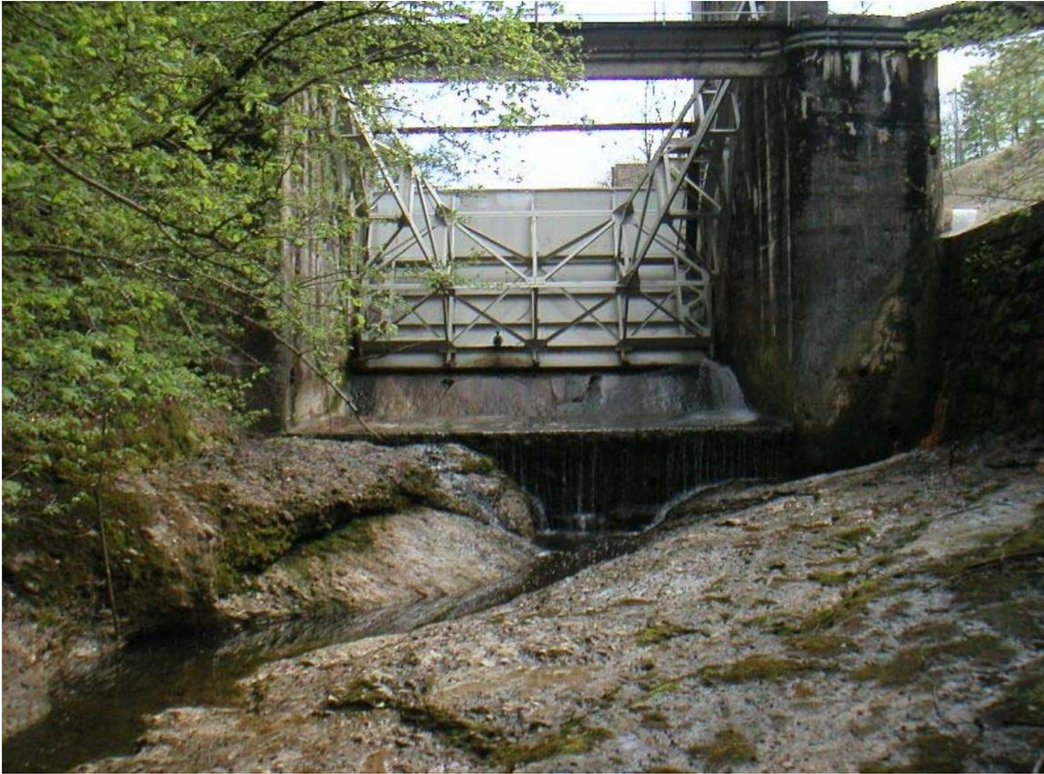
Auch lassen die alten Fassungskonstruktionen oft keine Restwasserdotierung zu
