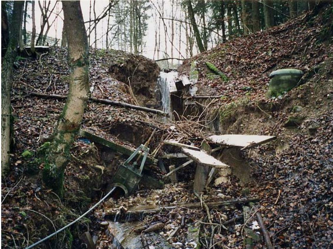
Altersbedingt weisen viele Anlagen Mängel durch innere und äussere Erosion sowie durch Setzungen auf.
