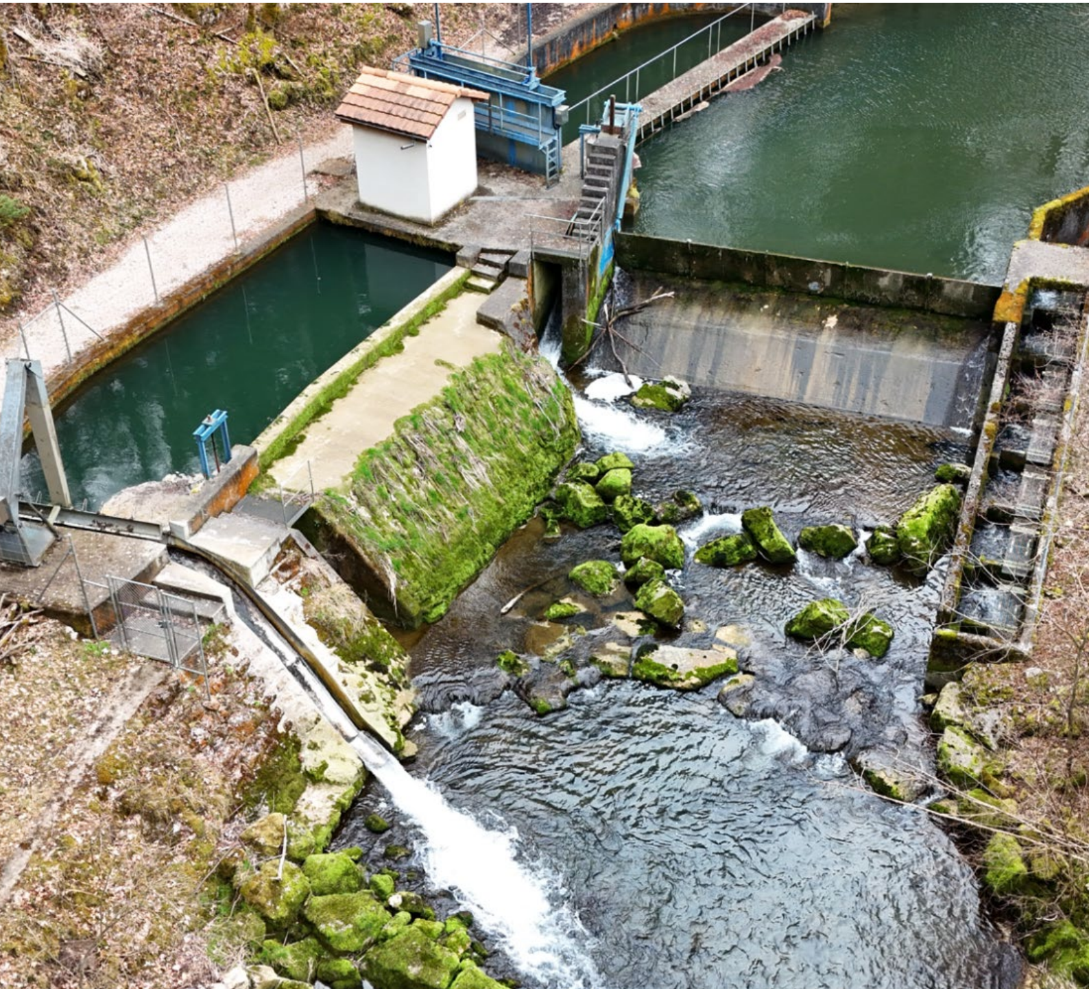
Wasserfassung der Kleinwasserkraftanlage Sonceboz Sous les Roches © Aquarius Sàrl, Jérôme Plomb, 2025
