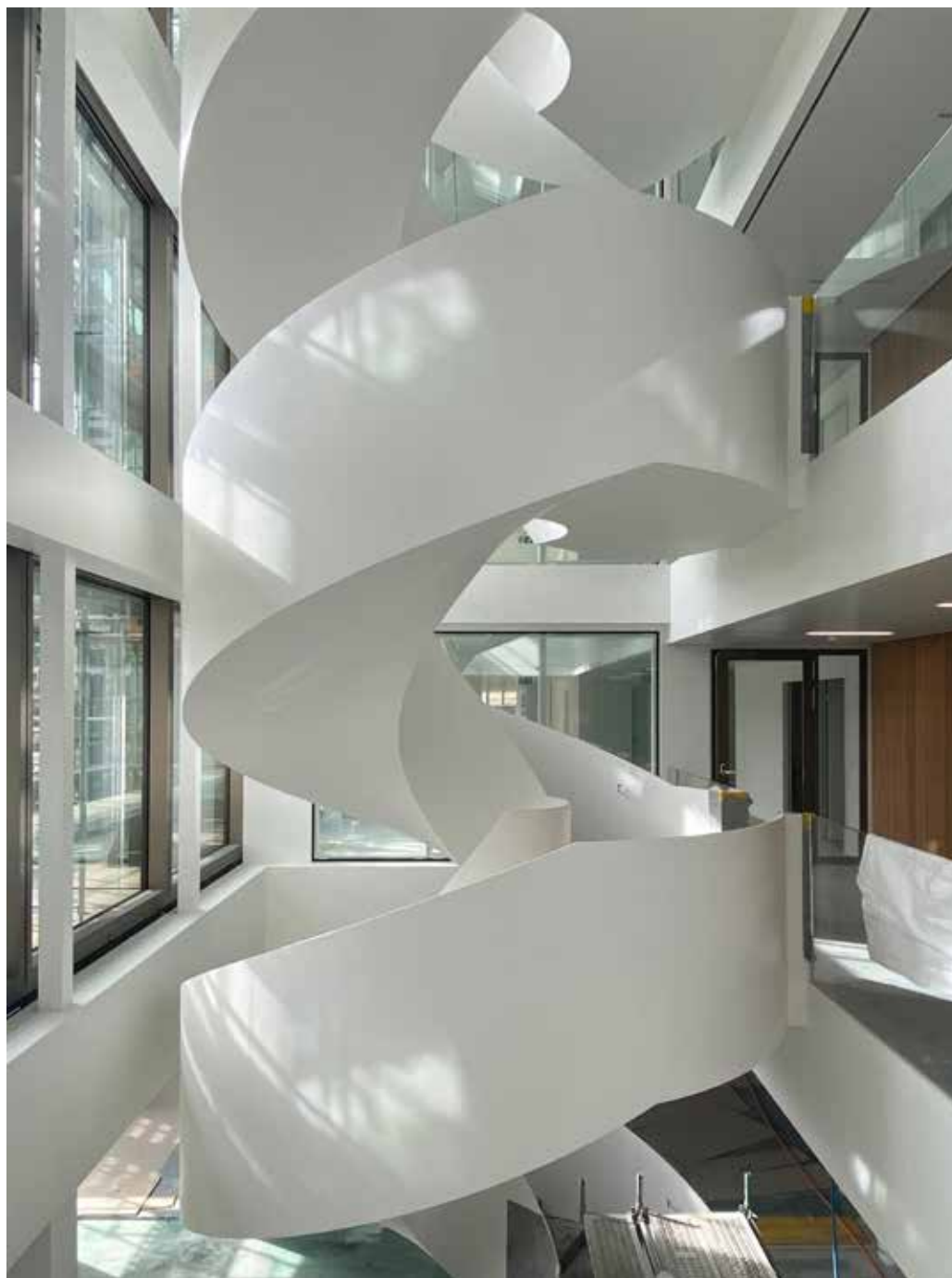
Der vertikale Durchbruch der verbindenden Halle war der grösste räumliche Eingriff bei der Sanierung.
