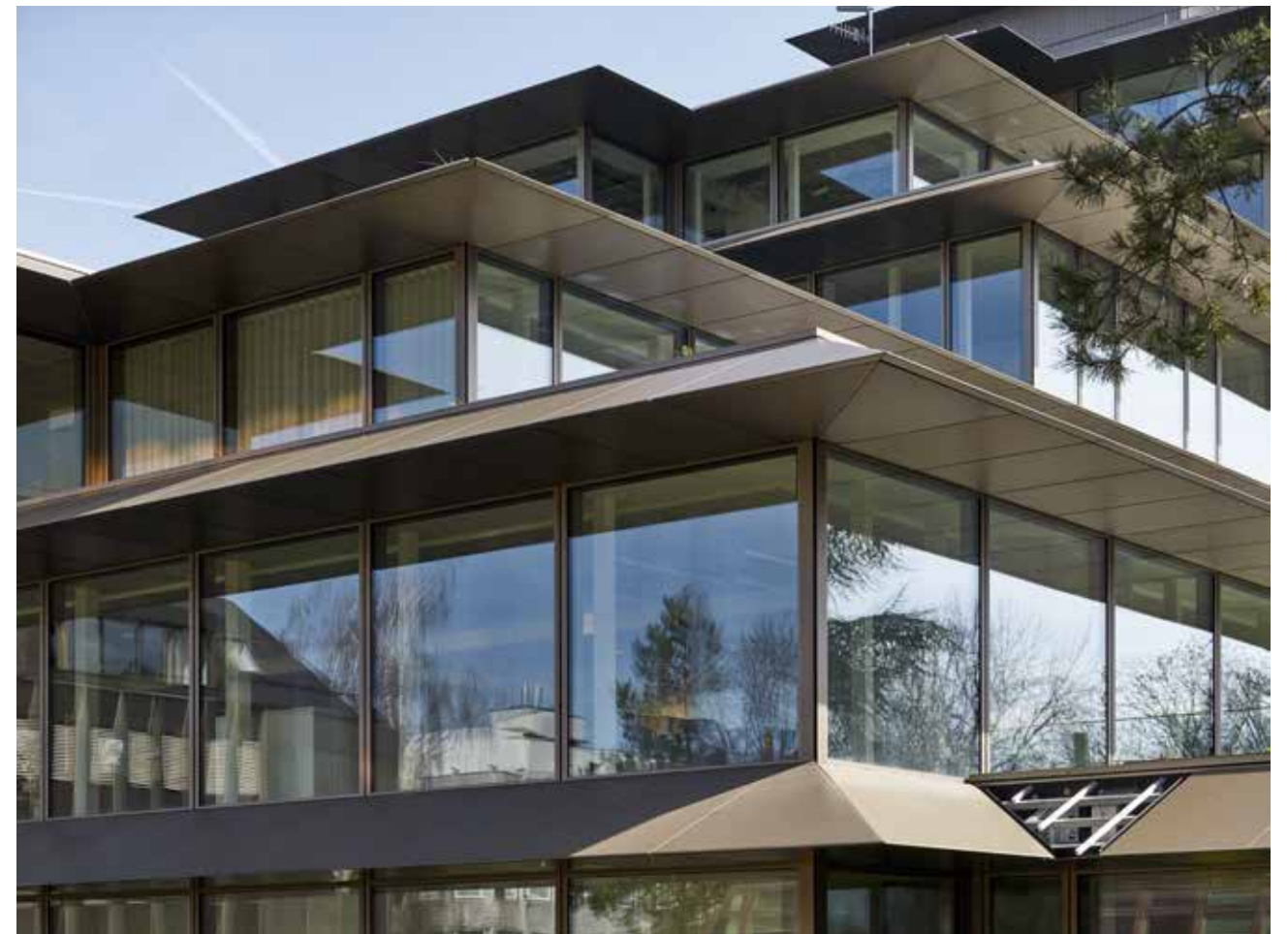
Unter- und Oberseite der Vordächer wirken gleich, bestehen aber aus unterschiedlichen Materialien.
