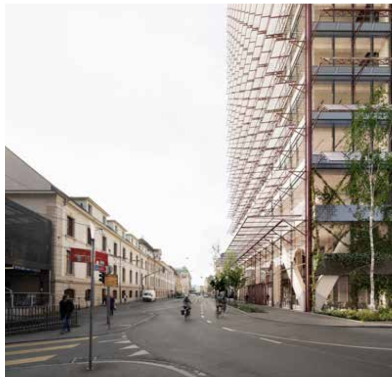
Die Photovoltaik-Anlage folgt im Tages- und Jahresverlauf dem Sonnenstand.
