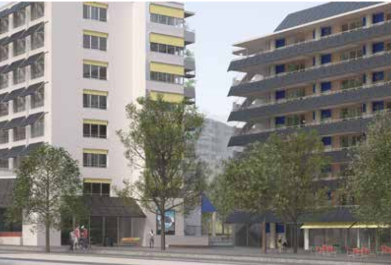
Die Solarmodule sind einmal als Vordach, einmal als Brüstung eingesetzt.
