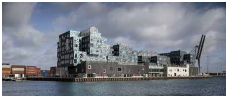
Die Photovoltaik-Fassade der Copenhagen International School ist rund 6000 Quadratmeter gross. Foto: Adam Moerk
