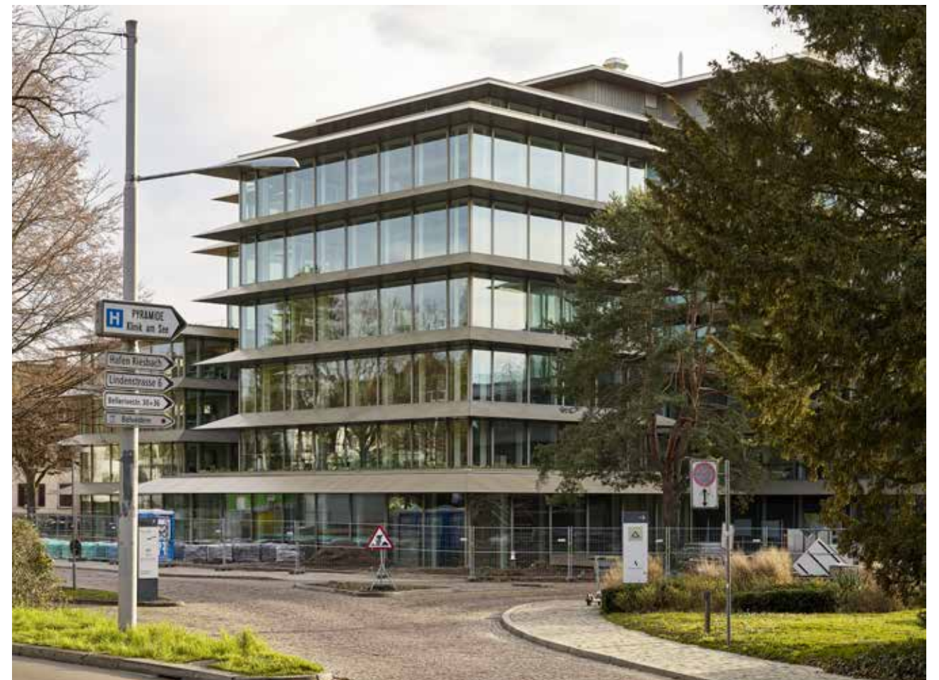
Auch wenn sich das Volumen des Bürohauses am Ufer des Zürichsees von 1974 kaum verändert hat, scheint dort heute ein neues Gebäude zu stehen.
