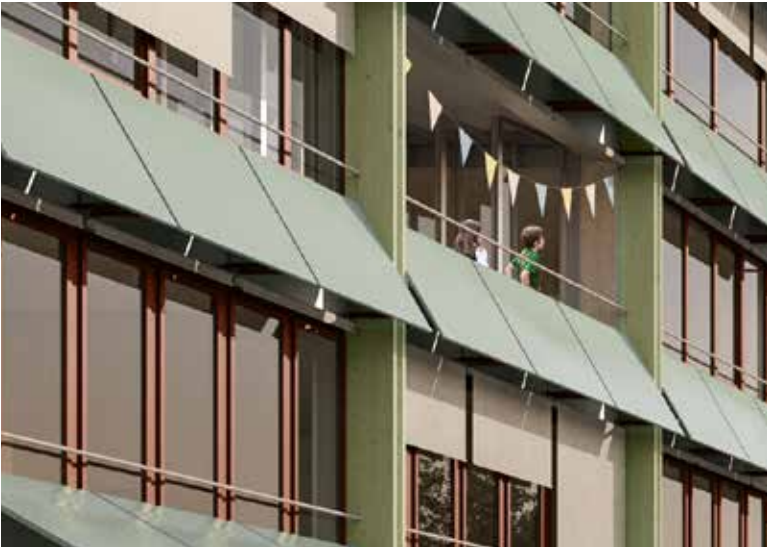
Schräge Brüstungsbänder mit Photovoltaik als selbstverständlicher Standard? Hier bei einem Schulhausprojekt der Architekten Bürgi Burkhard von Euw in Root.
