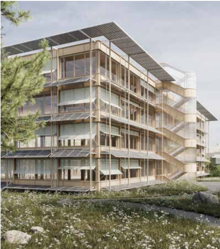
Umlaufende Bänder aus Photovoltaik verschatten die Innenräume des Holzbaus.
