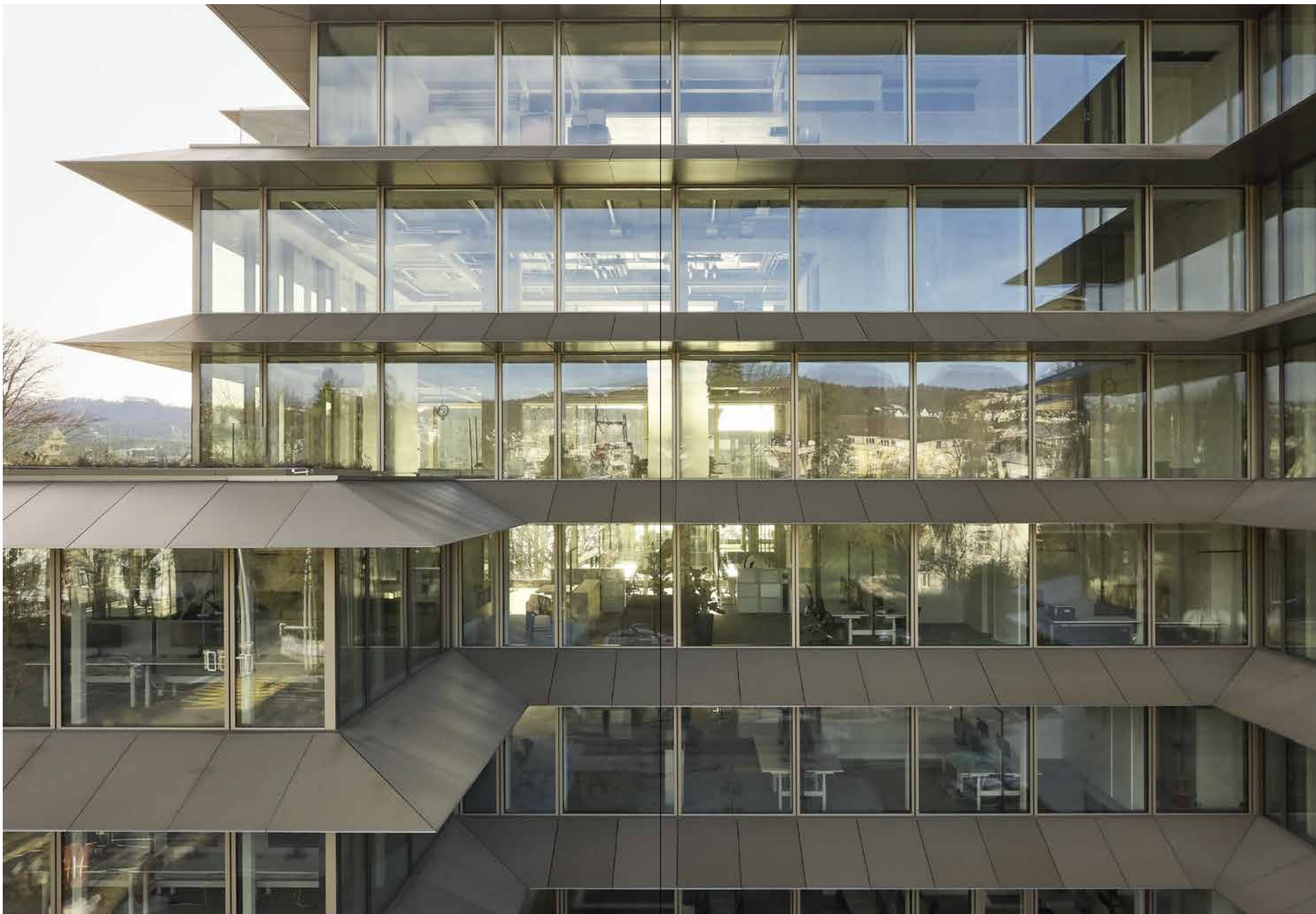
Durch die Vordächer braucht das Gebäude keinen aussenliegenden Sonnenschutz, und die Transparenz bleibt auch bei Sonnenschein gewahrt.
