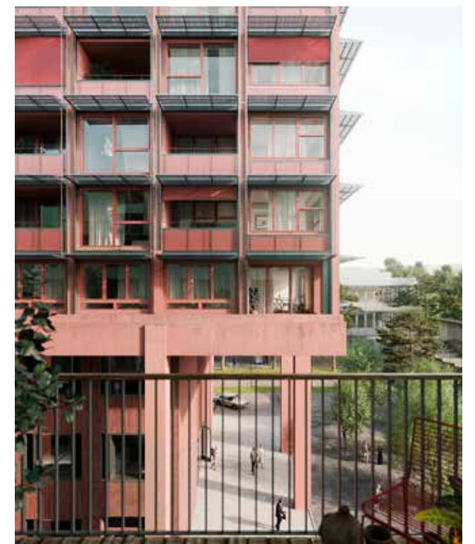
Die horizontal ausgestellten Solarmodule dienen auch als Brisesoleils.
