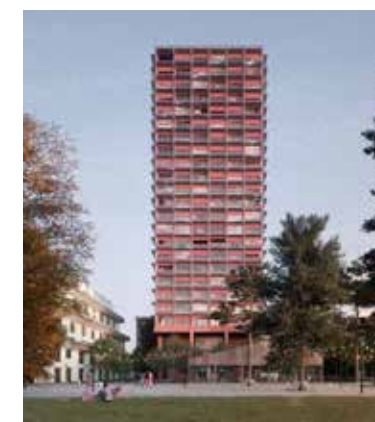
Die horizontal ausgestellten Solarmodule dienen auch als Brisesoleils.
