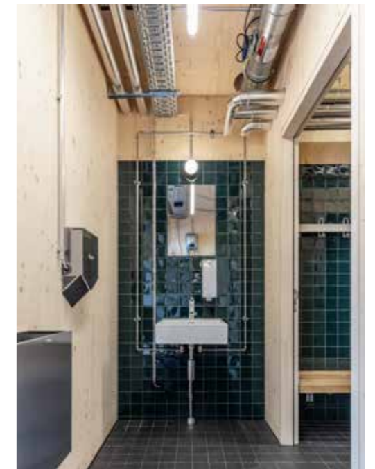
Die Rohre verlaufen sichtbar auf der Wand.
