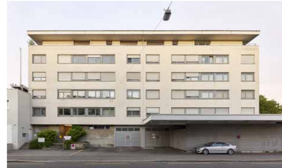
Das Haus aus den 1960er-Jahren vor der Fassadensanierung. Foto: Roman Weyeneth
