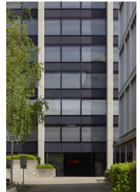
Den Brüstungsbändern sieht man nicht an, dass sie Strom produzieren.
