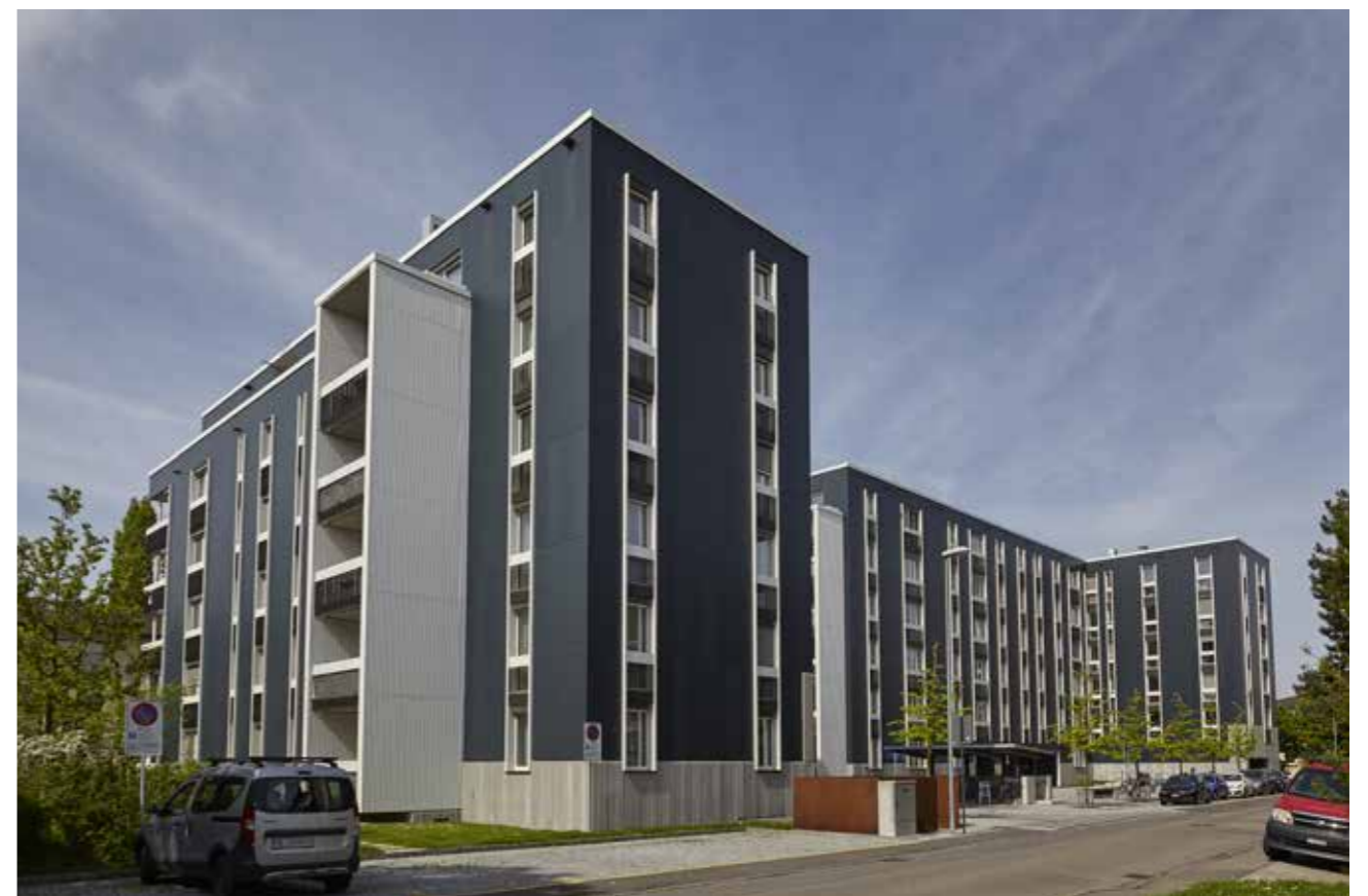
Die beiden Ersatzneubauten der Siedlung Heuwinkel bilden vor den Eingängen einen öffentlichen Platz.
