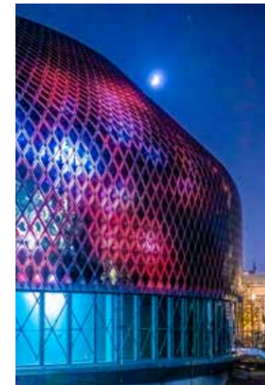
Die Blechhaut unter den Modulen reflektiert die Farbe der LEDs auf der Rückseite.
