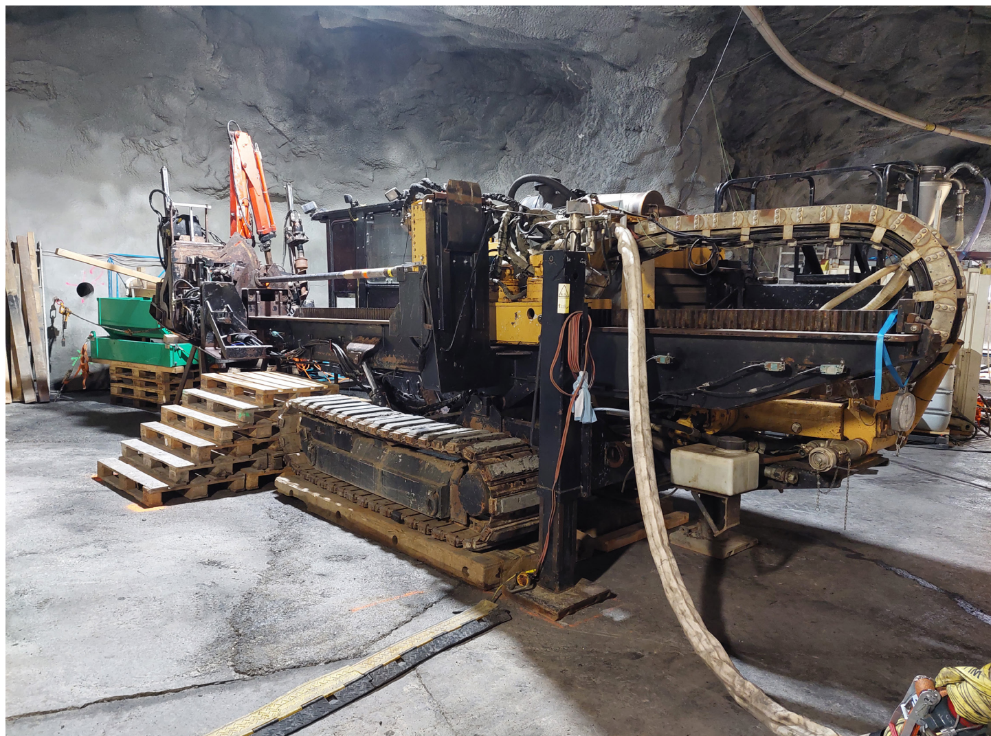
Versuchsstollen Hagerbach im Sarganserland: Hier wurde die DSSD-Bohrtechnik erprobt, indem zwei 125 Meter lange Bohrungen horizontal in den Berg getrieben wurden, der hier aus Kalkstein (Malm) besteht. Foto: ETH Zürich
