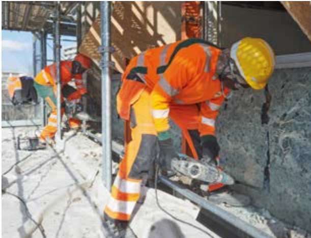
Abbildung 4.4: Aus einer ehemaligen Fassadenverkleidung entstand ein Terrazzo-Bodenbelag für die erneuerten Innenräume. (Fotos: Marcel Kohler/Eric Rossier)
