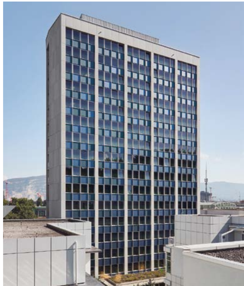
Abbildung 4.3: Der 16-geschossige Turm, der früher vom Duftstoff-Hersteller Firmenich genutzt wurde, erhielt durch farbige PV-Module an den Fassaden eine optische Auffrischung und erzeugt nun erneuerbaren Solarstrom. (Foto: Eric Rossier)
