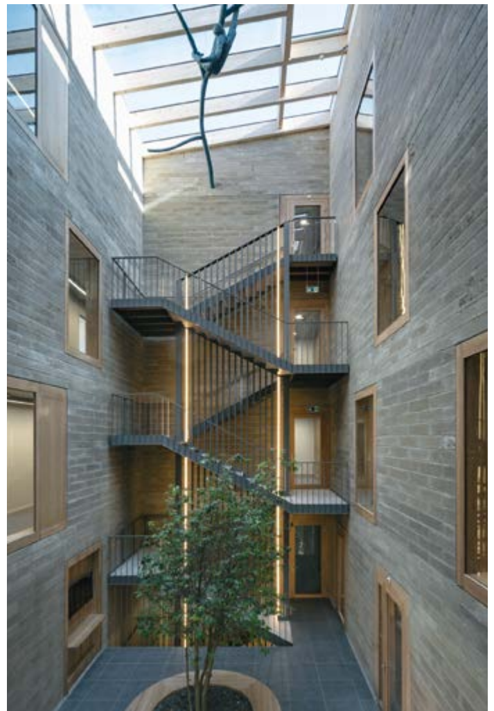
Abbildung 5.2: Eines der beiden Atrien, die nicht nur viel Tageslicht ins Gebäude bringen, sondern durch den Kamineffekt und die verbauten Lehmsteine auch das Raumklima positiv beeinflussen. (Foto: Duccio Malagamba)
