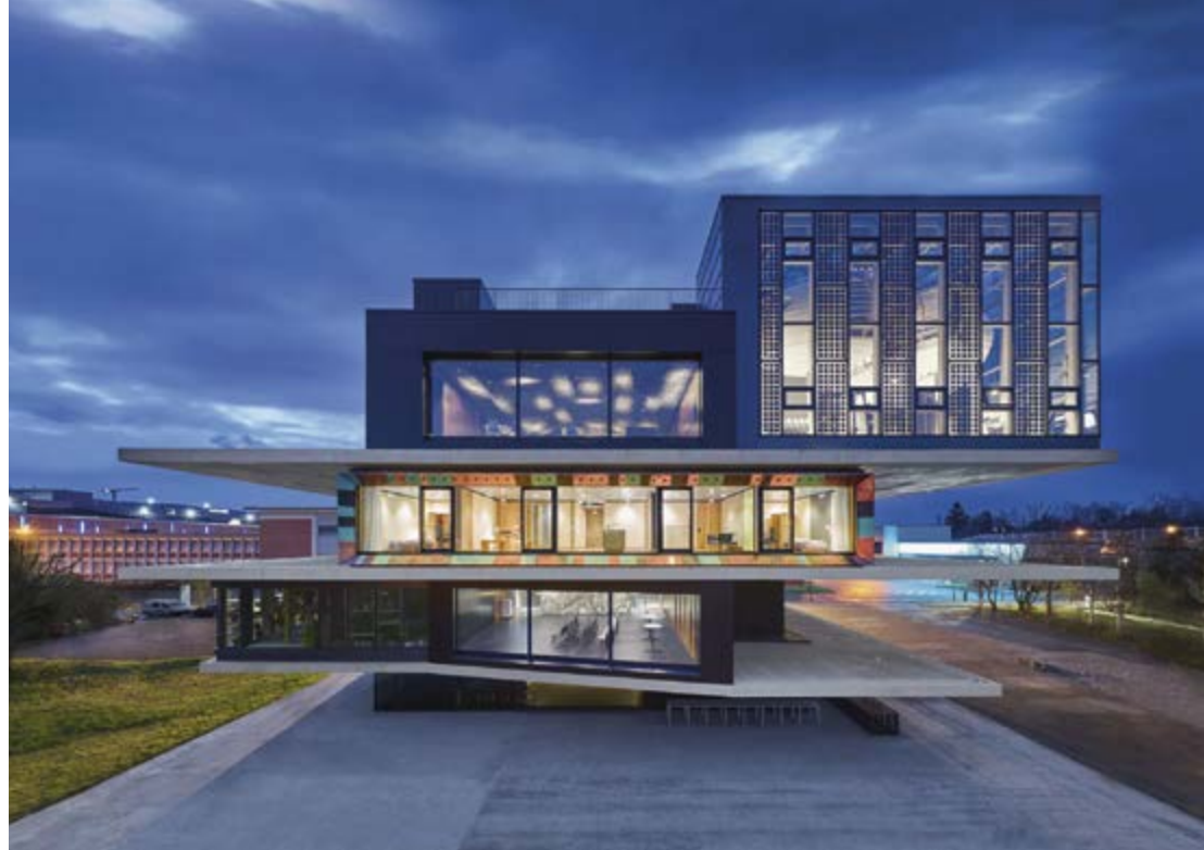
Abbildung 7.4: Die Unit «UMAR» befindet sich auf der mittleren Plattform. Gut zu erkennen sind die wiederverwendeten Kupferplatten unter und über den Fensterflächen: Die unterschiedlichen Farbtöne ergeben sich durch die Oxidation. (Foto: Zooey Braun, Stuttgart)
