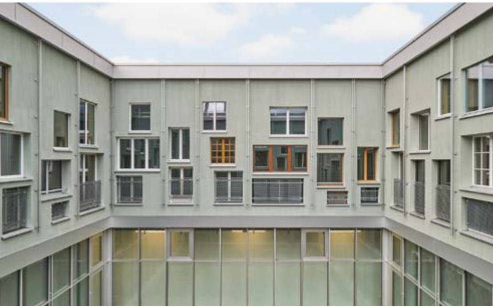
Abbildung 4.2: Beim Kultur- und Gewerbehaus Elys in Basel wurden 200 Fenster wiederver- wendet, die sich in Farbe, Form und Material stark unter- scheiden. (Foto: baubüro in situ/ Martin Zeller)
