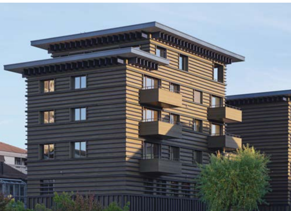
Abbildung 6.4: Das «Haus des Holzes» ist fast vollständig mit lokalem Holz erbaut. (Foto: Marcoleu GmbH)
