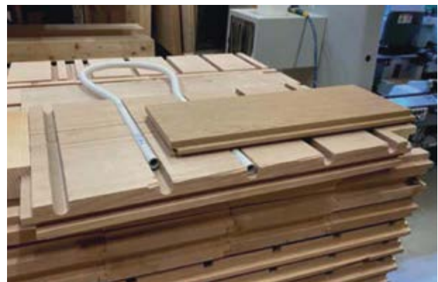
Abbildung 6.2: Bodenaufbau in den Bürogeschossen des «Haus des Holzes». Die Rohre des Heiz- und Kühlsystems sind nicht eingegossen, sondern lassen sich einfach wieder trennen. (Quelle: PIRMIN JUNG Schweiz AG)
