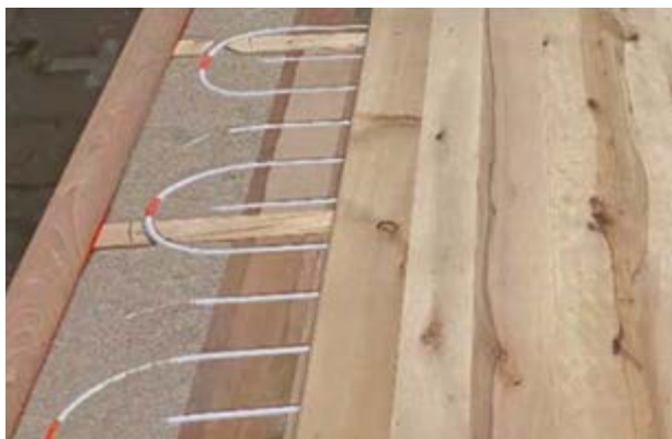
Abbildung 6.2: Bodenaufbau in den Bürogeschossen des «Haus des Holzes». Die Rohre des Heiz- und Kühlsystems sind nicht eingegossen, sondern lassen sich einfach wieder trennen. (Quelle: PIRMIN JUNG Schweiz AG)
