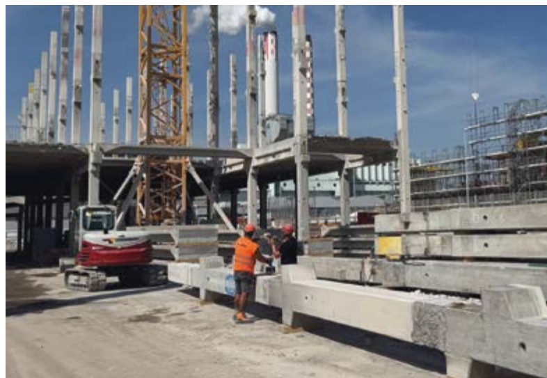
Abbildung 7.3: Stützen, Träger und Deckenelemente des ehemaligen Parkhauses Lysbüchel in Basel werden elementweise rückgebaut und sollen danach in zwei Neubauten wiederverwendet werden. (Bild: Muriel Mangold, Immobilien Basel-Stadt)
