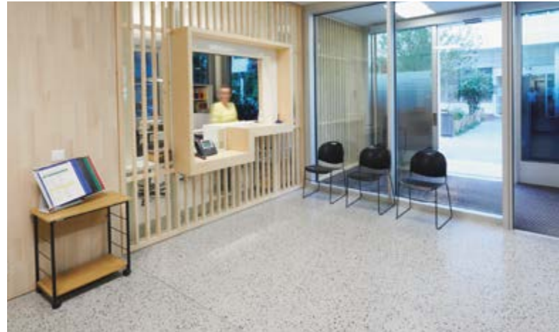
Abbildung 4.4: Aus einer ehemaligen Fassadenverkleidung entstand ein Terrazzo-Bodenbelag für die erneuerten Innenräume. (Fotos: Marcel Kohler/Eric Rossier)
