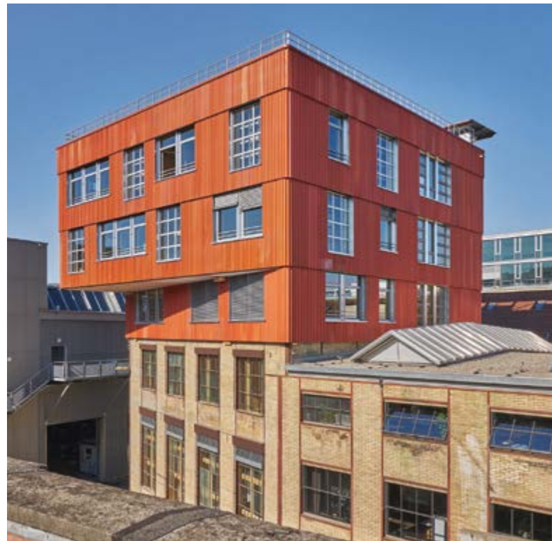
Abbildung 1.3: Die Fassade und die Tragstruktur des dreistöckigen Kopfbaus der Halle 118 auf dem Lagerplatz in Winterthur bestehen mehrheitlich aus wiederverwendeten Bauteilen. (Foto: baubüro in situ/Martin Zeller)
