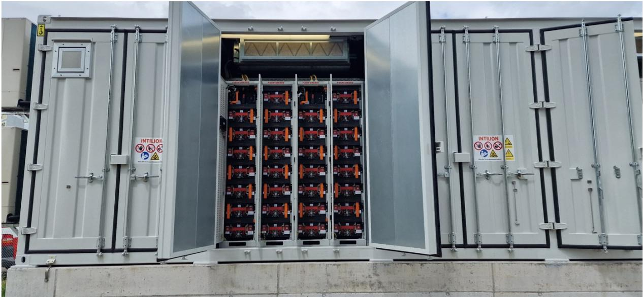
**Abbildung 2:** Die Powerbank von innen. Die vier Containerabteile enthalten je 60 Lithium-Eisen-Phosphat-Batterien (LFP). Sie sind komplett kobalt- und nickelfrei und deutlich nachhaltiger als herkömmliche Batterien.
