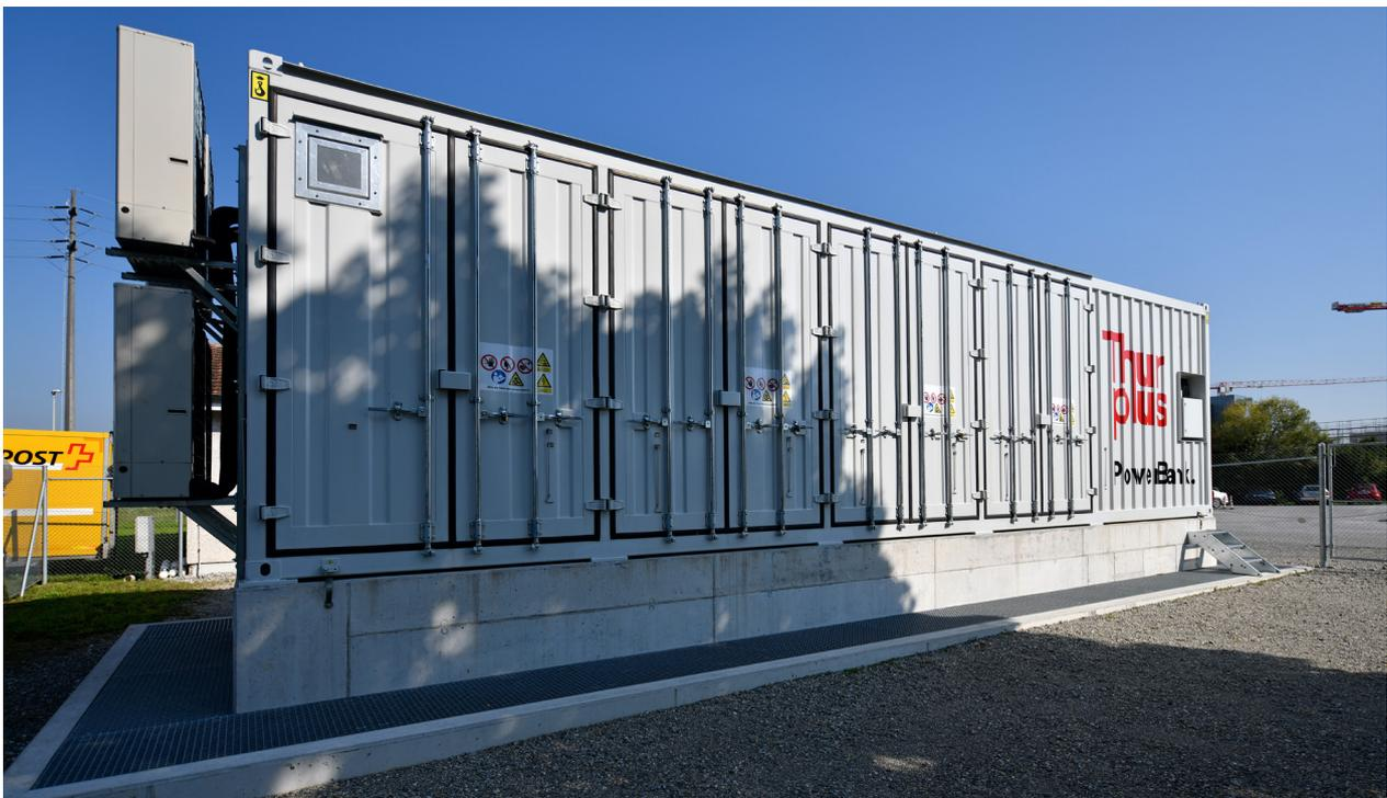
**Abbildung 1:** Die Powerbank in Frauenfeld mit einer Leistung von 3 Megawatt und einer Speicherkapazität von 3'000 Kilowattstunden speichert Strom, sorgt für Netzstabilität, glättet Lastspitzen und stärkt die Versorgungssicherheit
