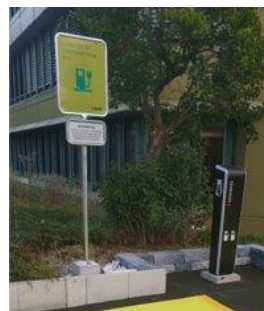
Abbildung 15 Beispiel einer Beschilderung eines Ladepunktes
