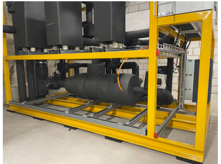
Eine Radialpumpe, wie sie im ETS im Prodega-Markt St. Gallen im Einsatz ist. Pumpe und Motor sind in einem Stahlgehäuse mit 130 bar Druckbeständigkeit untergebracht. Diese halbhermetische Bauweise beugt Leckagen vor, wie sie bei der Kolbenpumpe im Prodega-Markt Dietikon aufgetreten waren. Foto: Frigo-Consulting AG
